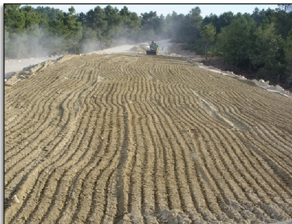
Figura 4.14 – Solo escarificado
