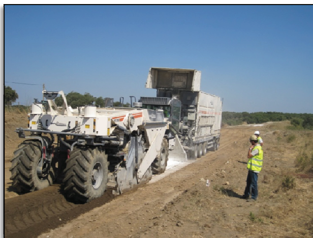
Figura 6.32 – Aplicação de cal no trecho experimental
