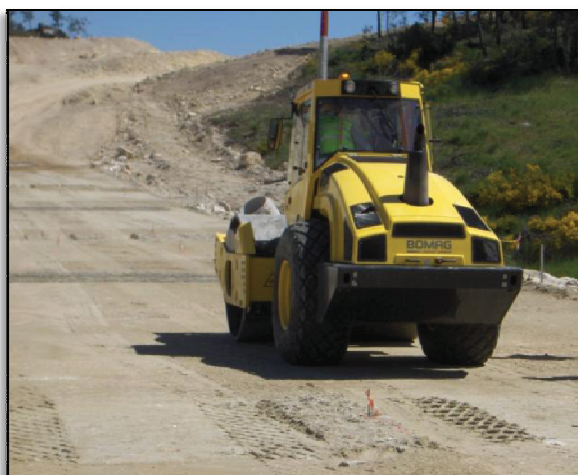
Figura 4.9 – Equipamento munido com sistema de controlo de compactação inteligente (Fonte: Parente, 2010)
