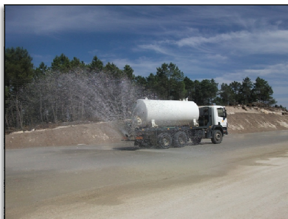
Figura 4.13 – Camião cisterna aplicando água sobre o material seco
