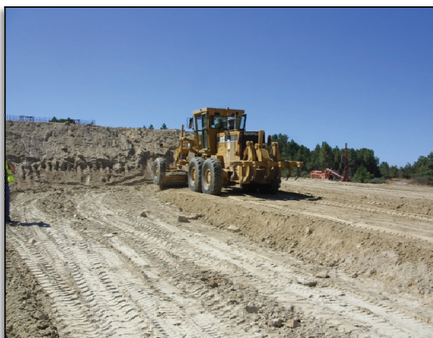
Figura 4.16 – Motoniveladora equipada com riper
