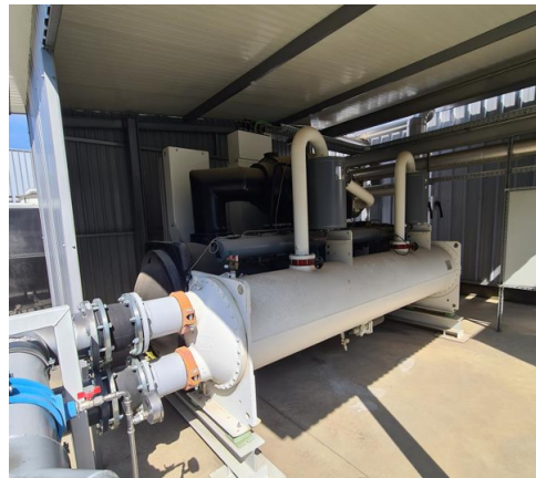
Figura 3.4: Unidade de arrefecimento de água 4 [1]
