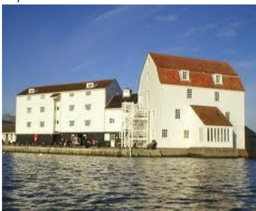
Figura 10 - Moinho de maré de Woodbridge, Suffolk ("Woodbridge Tide Mill", 2007)
