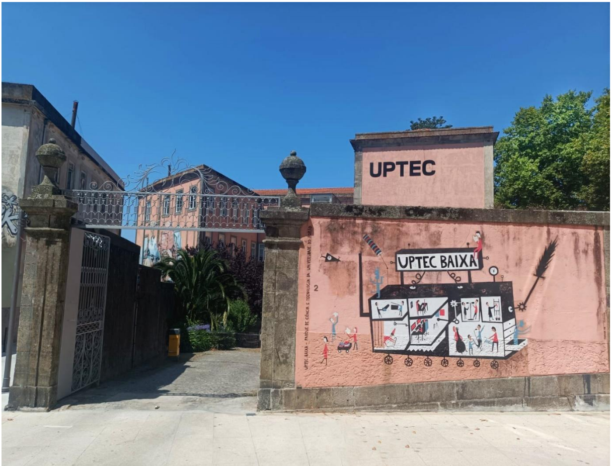
Figura 1 – Edifício 1 da UPTEC Baixa.
