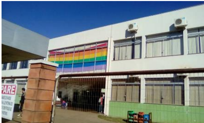
Figura 7 - Bandeira horizontal, instalada na Biblioteca. Fonte: C. Pinheiro, 2017.
