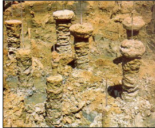
Figura 3.6 – Colunas de jet-grouting executadas (Fonte: NEVES, 2010 apud PINTO [s.d.]).
