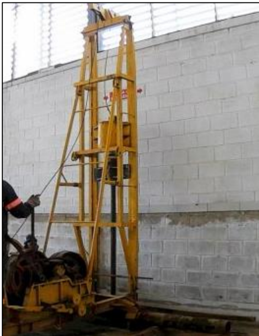
Figura 3.11 – Execução de microestacas (Fonte: site TEC GEO, 2018).
