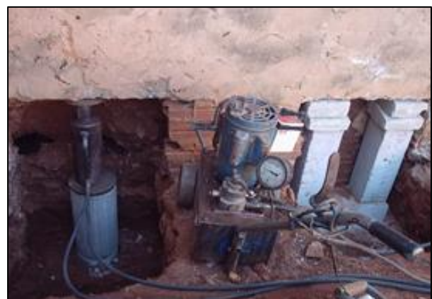
Figura 3.10 – Instalação de estacas mega (Fonte: site REFORT FUNDAÇÕES, 2018).
