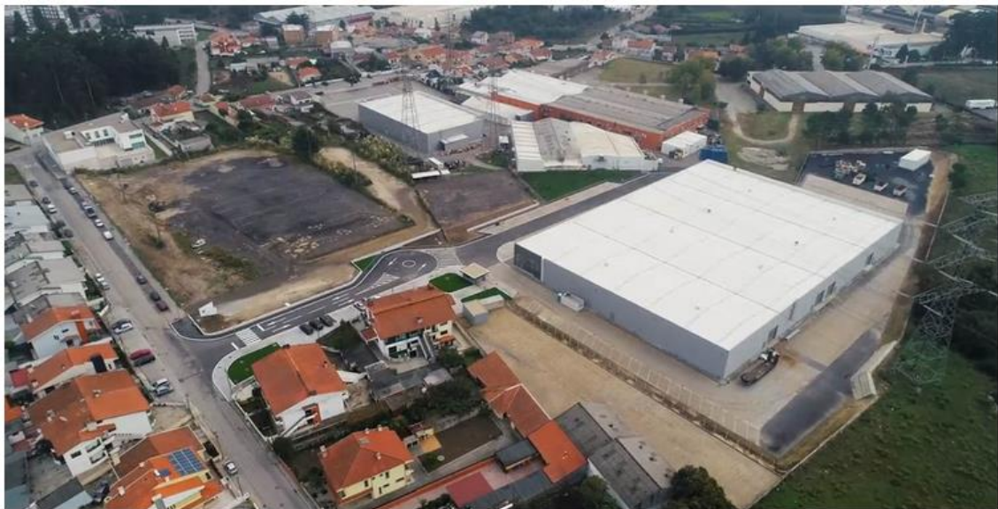
Figura 16 - Instalações da Fico Cables na Maia
