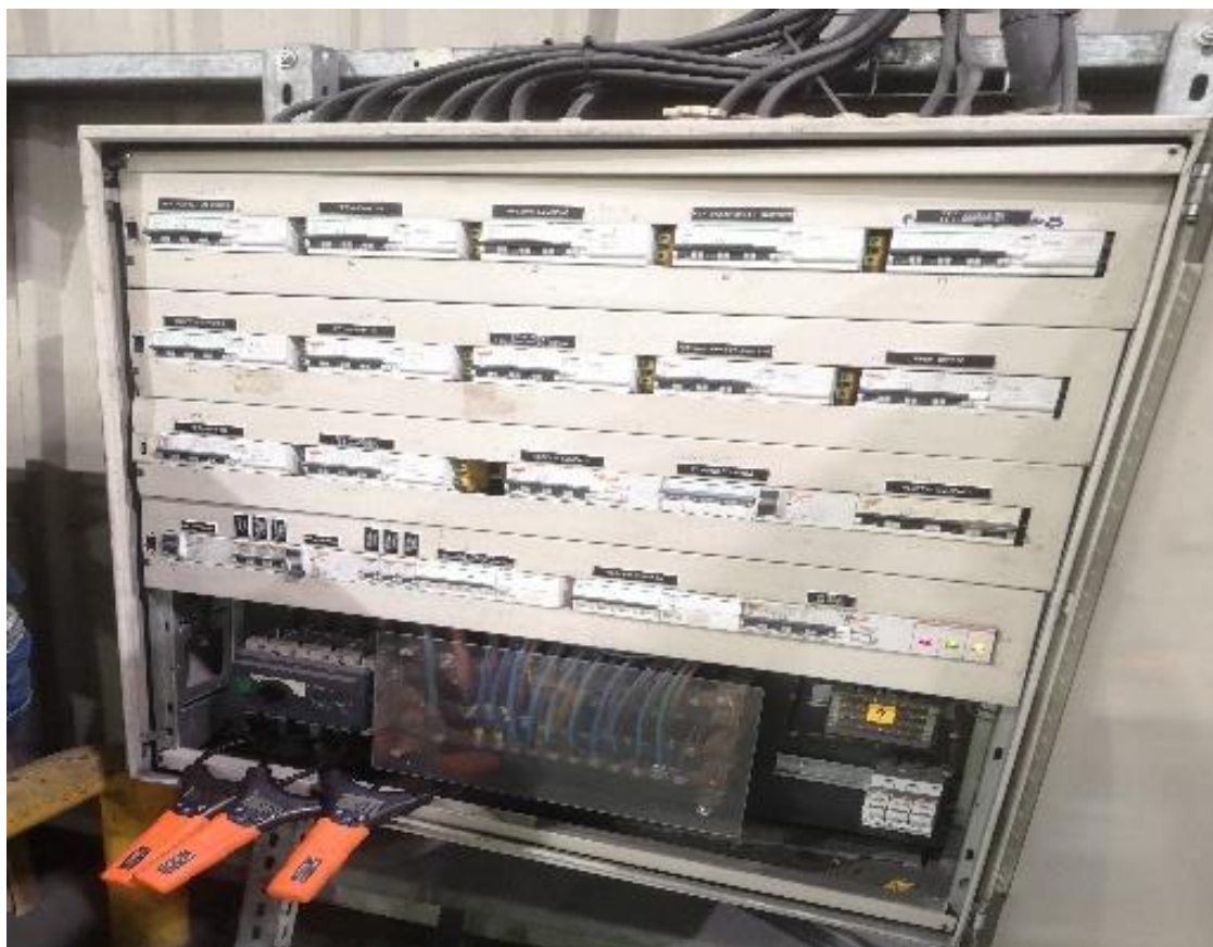
Figura 57 - Exemplo de medição de corrente consumida
