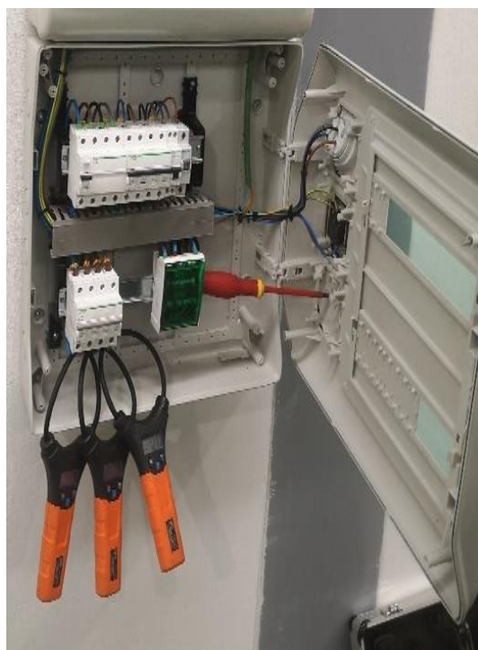
Figura 55 – Exemplo de medição de corrente consumida
