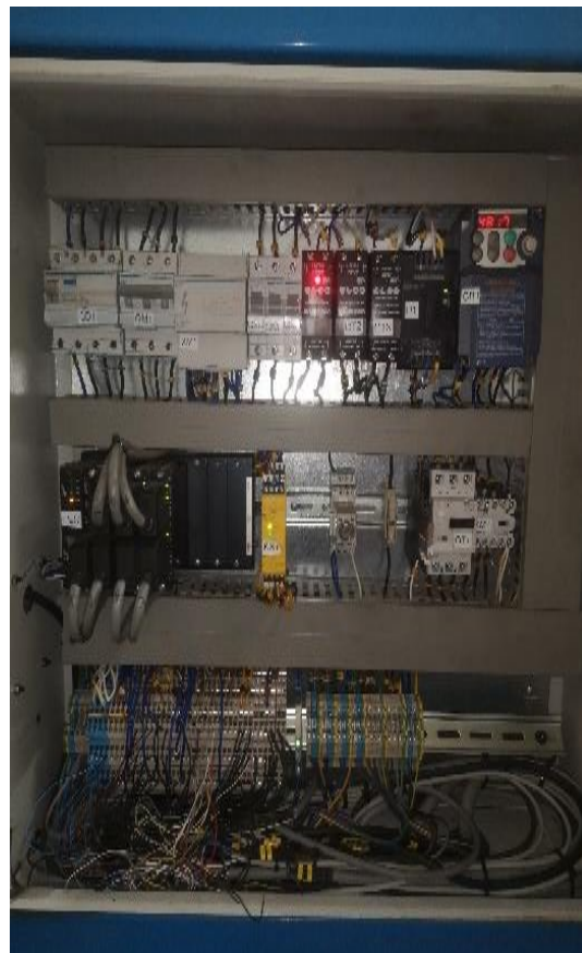
Figura 37 - Quadro individual de máquina aberto
