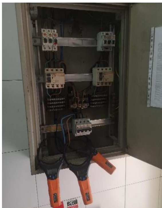
Figura 56 - Exemplo de medição de corrente consumida
