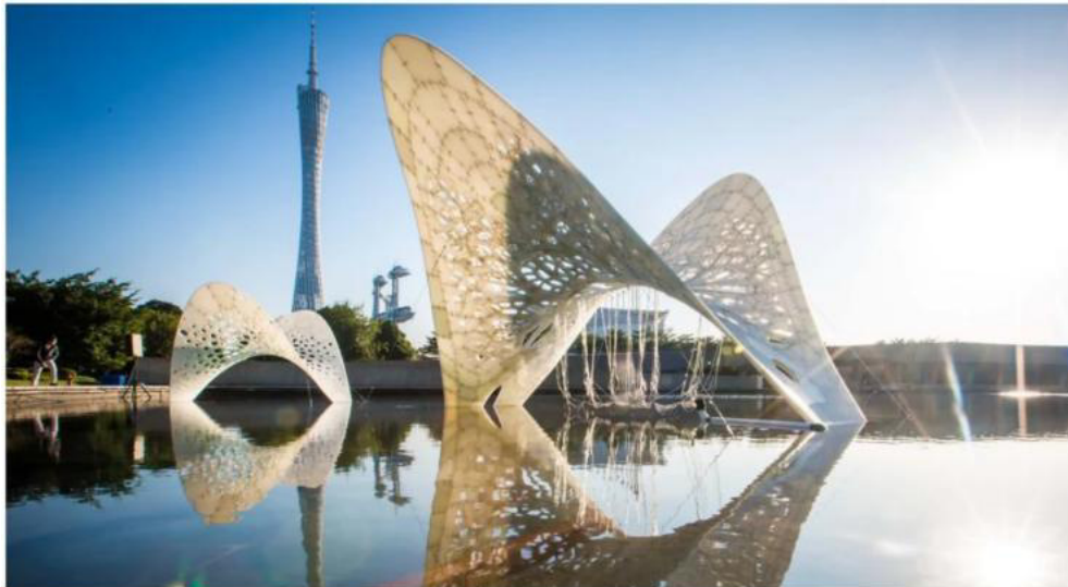
Figura 29 Estrutura modular impressa em 3D com design paramétrico, construída em frente ao Guangzhou Opera House.
