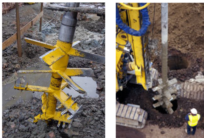
Figura 35: Equipamentos para a realização de tratamento tipo Deep Soil Mixing. (Fonte: Advanced Geosolutions Inc, 2006)
