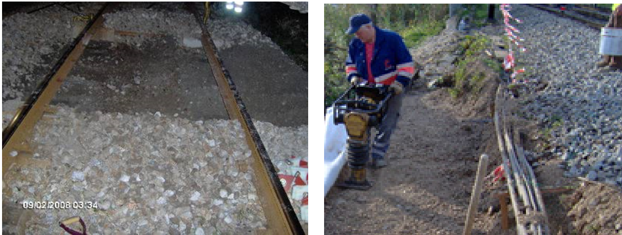
Figura 68: Remoção da camada de sub-balastro na Linha de Cascais (esquerda) e compactação de solos na Linha de Sintra (direita). (Fonte: da autora, 2008)
