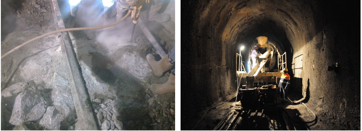
Figura 70: Furação na base da plataforma (esquerda) e abastecimento da máquina de injeções (direita) na Linha do Minho. (Fonte: da autora, 2011)
