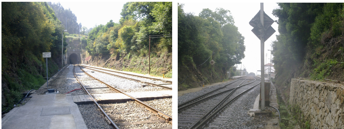
Figura 48: Zona intervencionada junto á boca de saída do túnel de Tamel da Linha do Minho. (Fonte: da autora, 2012)
