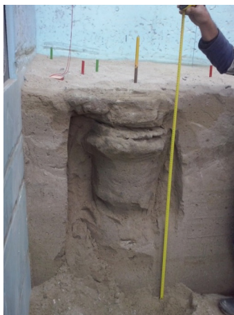
Figura 41: Pormenor da coluna provocada pela segunda injeção S.I.E3.
