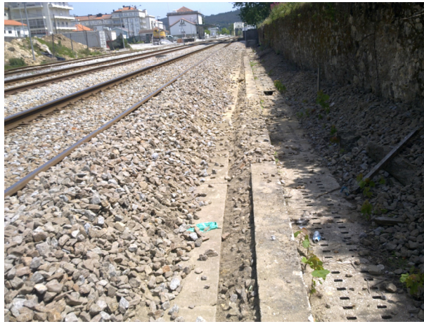
Figura 27: Valetas de plataforma com tampa junto á Estação de Caminha na Linha do Minho. (Fonte: da autora,2012)
