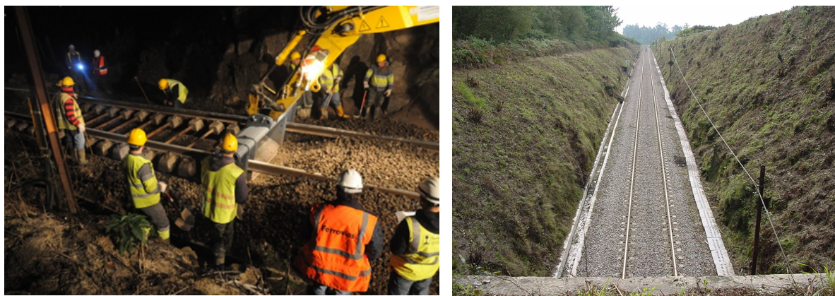
Figura 45: Zona intervencionada junto á boca de entrada do túnel de S. Miguel de Carreira na Linha do Minho, durante a intervenção á esquerda e concluída á direita. (Fonte: da autora, 2010)
