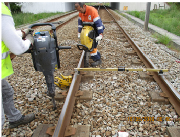
Figura 80: Trabalhos na via-férrea sem necessidade de interdição de via temporária. (Fonte: da autora, 2017) São então estas as classes introduzidas no modelo de decisão apresentado e caracterizam as atividades em função do que estas necessitam para se desenvolverem permitindo ao técnico avaliar
