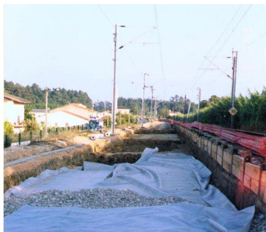
Figura 26: Substituição do solo da plataforma da via. (Fonte: E. Fortunato,2014)
