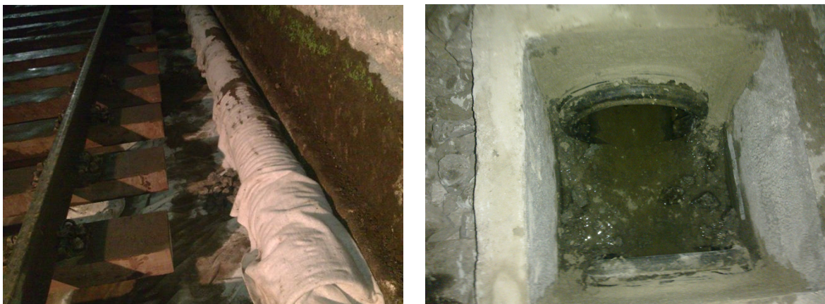
Figura 69: Colocação de tubo longitudinal envolto em geotêxtil (esquerda) e pormenor de caixa de visita e desobstrução á drenagem profunda (direita) na Linha do Minho. (Fonte: da autora, 2011)
