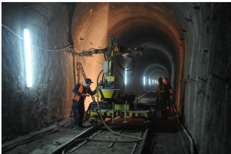
Figura 42: Coluna de furação instalada num suporte com bogies no túnel de Tamel na Linha do Minho. (Fonte: da autora, 2010)
