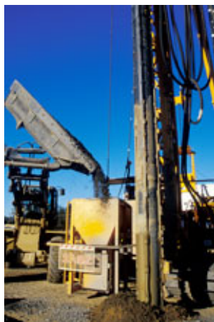
Figura 39: Equipamento para a realização de tratamento tipo vibrosubstituição. (Fonte: Advanced Geosolutions Inc, 2006)
