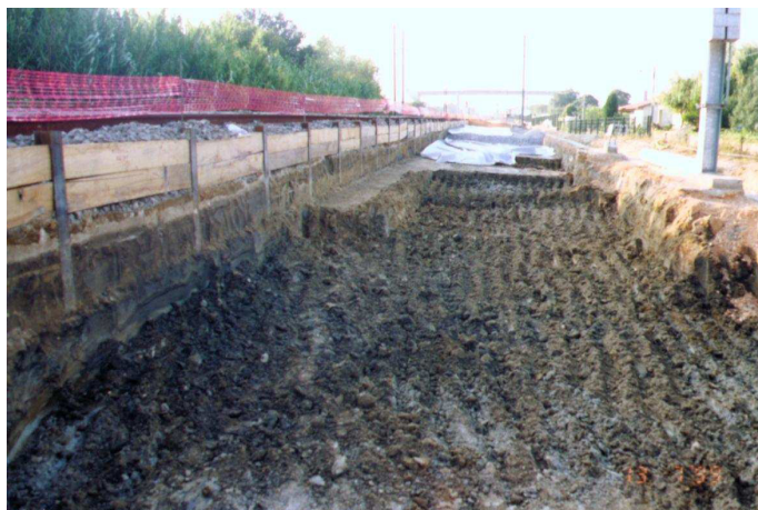
Figura 19: Reabilitação integral da plataforma de via. (Fonte: E.Fortunato, 2014)
