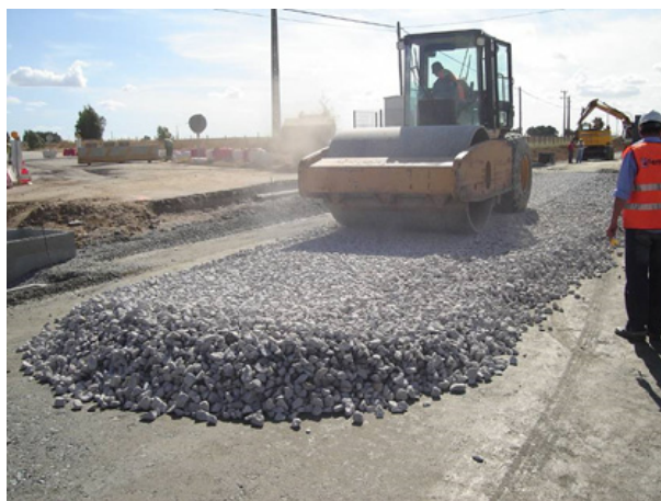
Figura 24: Compactação da plataforma da via. (Fonte: Portfólio MEEC)
