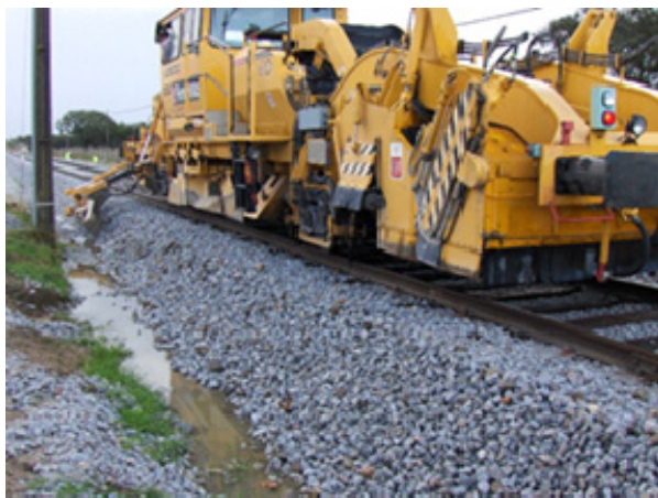
Figura 79: Regularizadora mecânica de balastro. (Fonte: portefólio MEEC)
