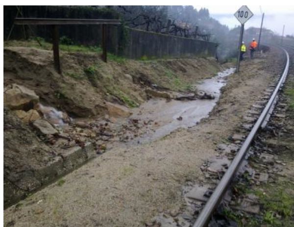
Figura 76: Contaminação da plataforma da via através das águas da drenagem – Linha do Minho. (Fonte: da autora, 2011)
