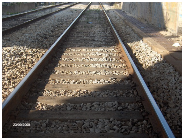
Figura 6: Via assente em travessas de madeira de pinho na Linha de Cascais. (Fonte: da autora, 2008)
