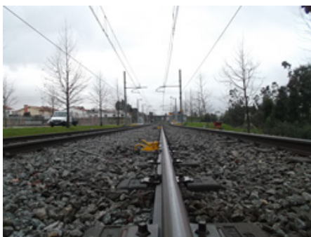
Figura 1: Retificação de nivelamento em via balastrada no Metro do Porto. (Fonte: da autora, 2004)
