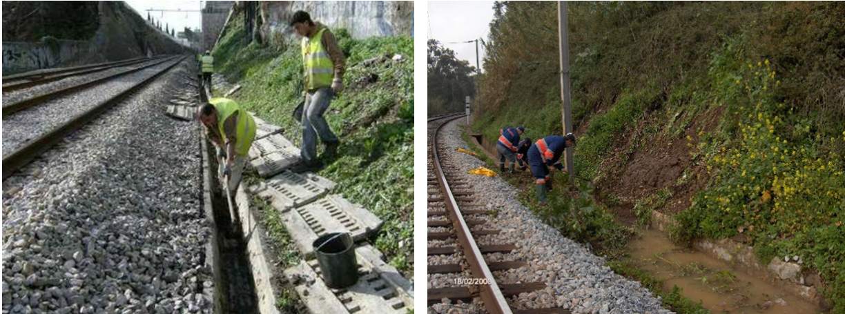
Figura 66: Limpeza de órgãos de drenagem na Linha de Cascais (esquerda) e na Linha de Sintra (direita).
