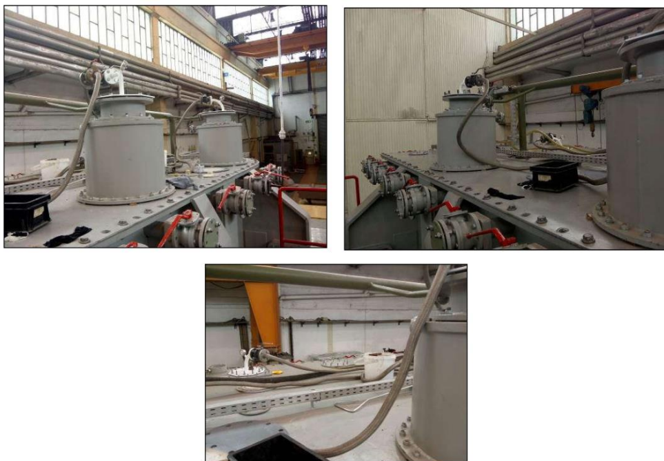
Figura 5.26 - Montagem dos sprays para o circuito do óleo de circulação
