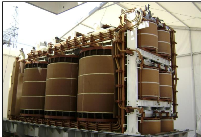
Figura 2.5 - Parte ativa de um transformador durante uma descubagem para reparação
