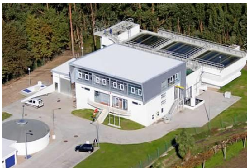
Figura 3.7 – ETA de Ferreira [4]
