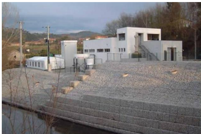
Figura 3.6 – ETA do Ferro [4]
