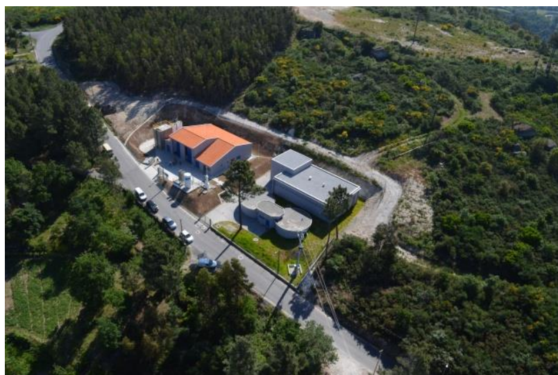
Figura 3.9 – ETA de Pousada-Gôve [4]
