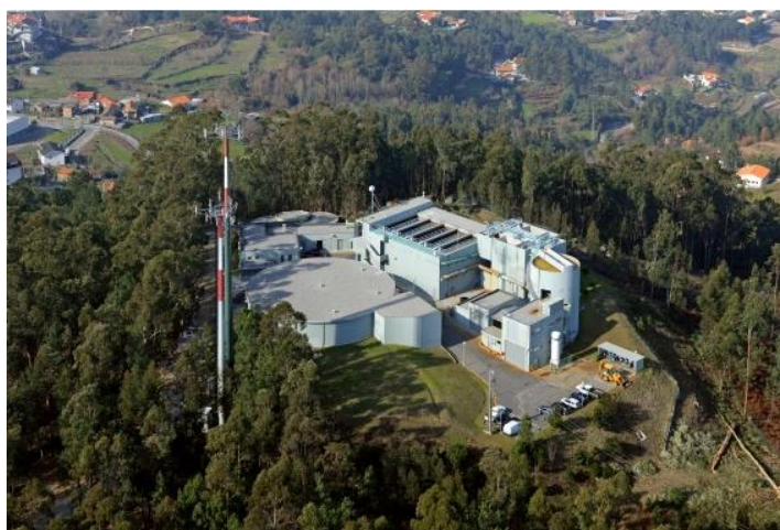
Figura 3.5 – ETA de Castelo de Paiva [4]
