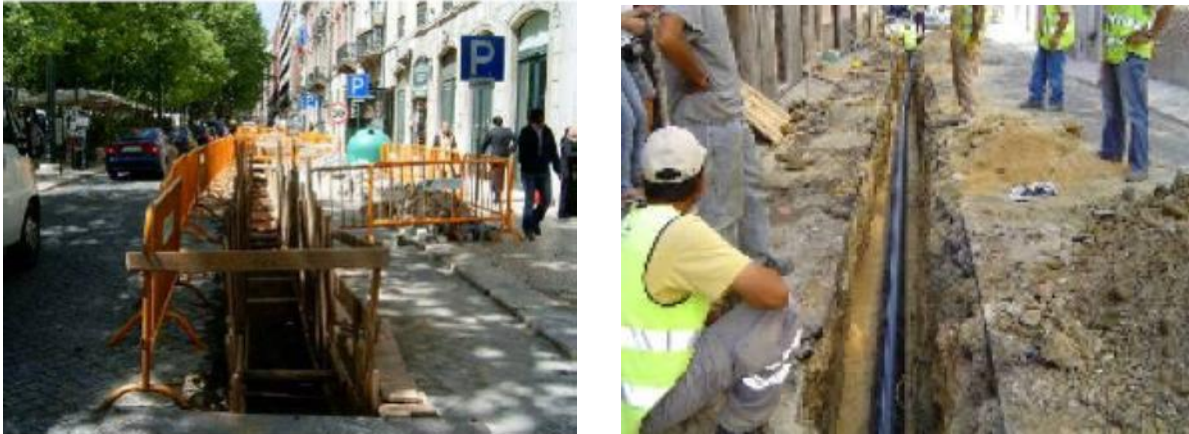
Figura 4.7 – Substituição com vala aberta [26]
