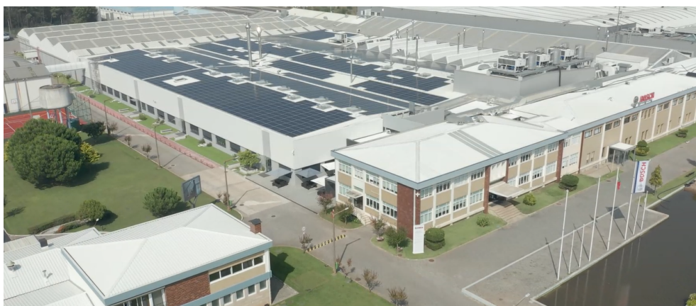
Figura 4.17: Painéis instalados na cobertura da área de produção.
