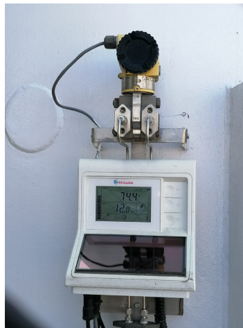
Figura 4.25: Sistema de telemetria do nível de azoto no depósito.
