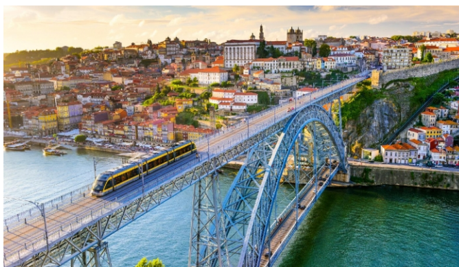
Figura 10 - Ponte Luís I
