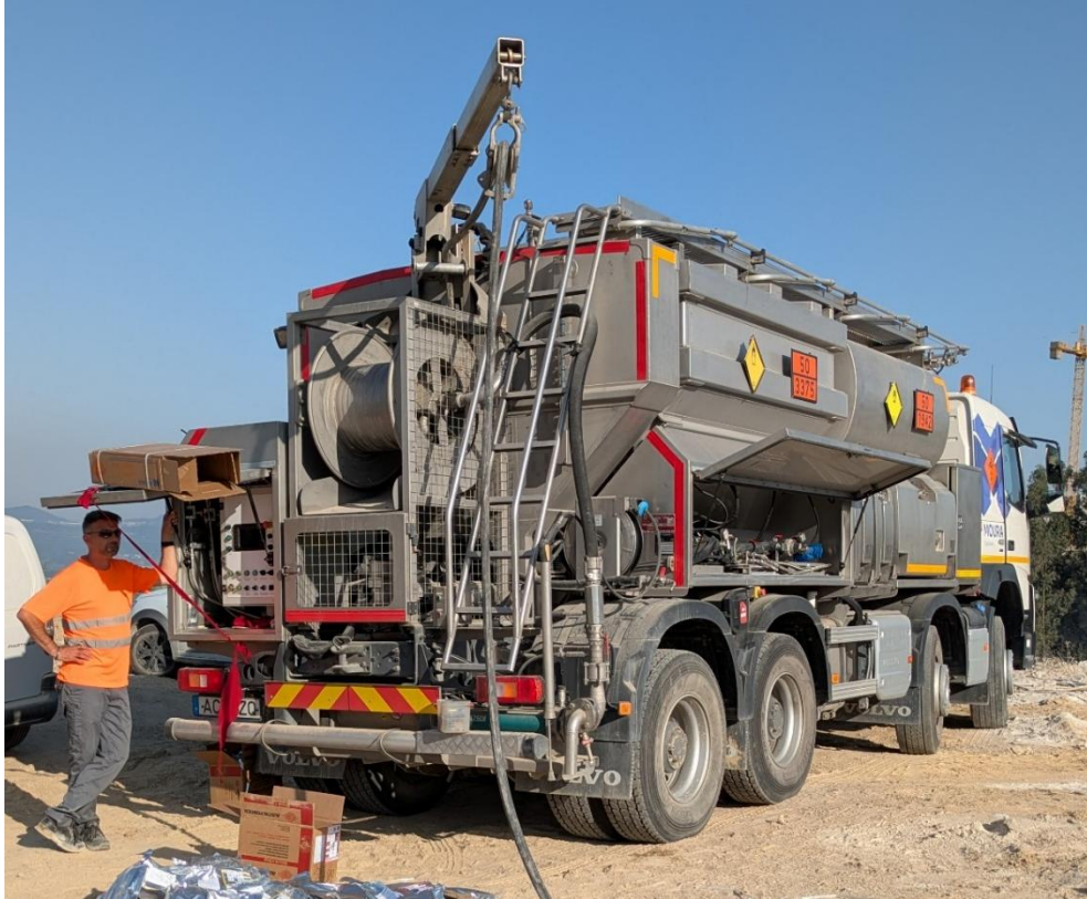
Figura 35- Camião cisterna especializado para o carregamento e aplicação da mistura explosiva.
