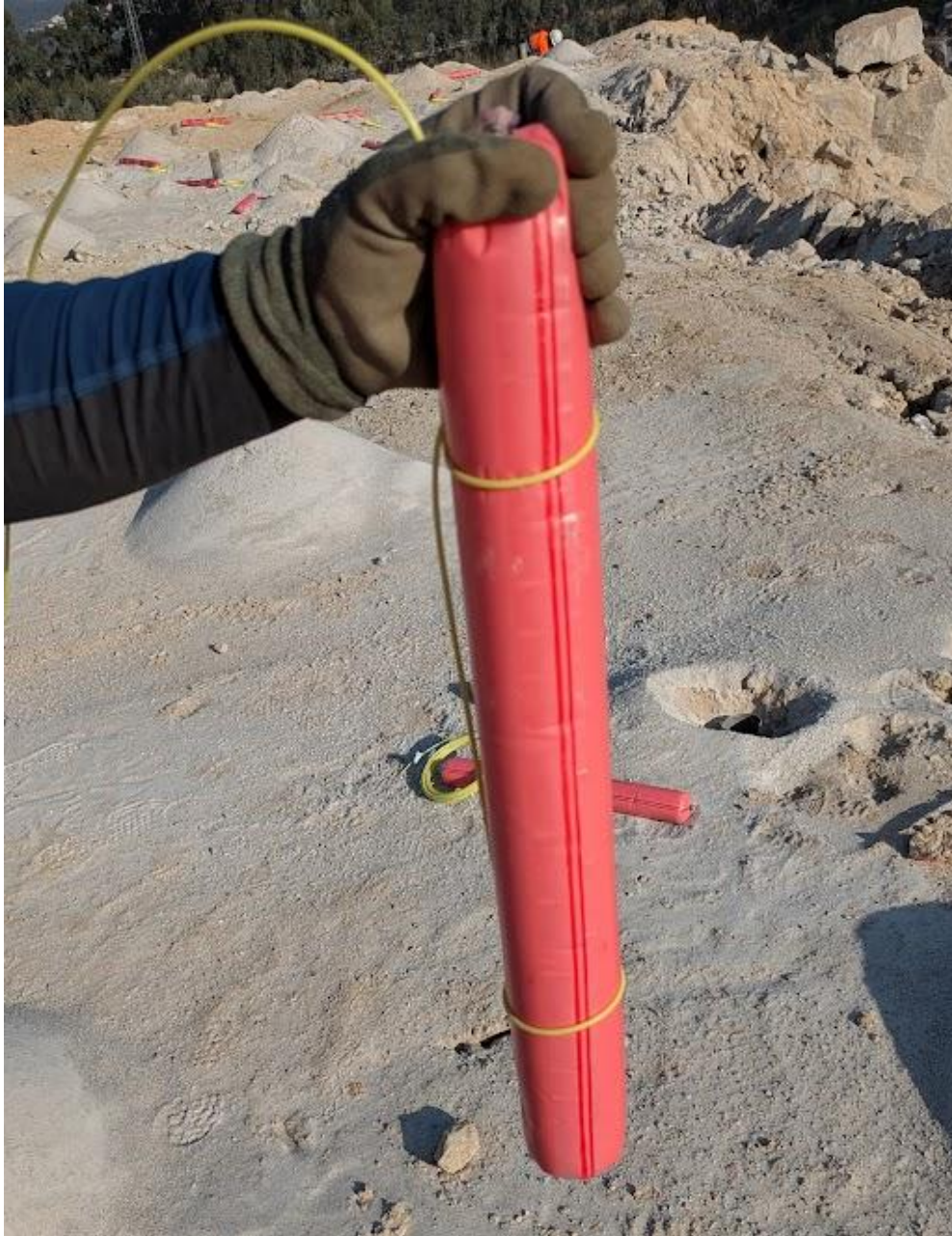
Figura 22– Exemplo de detonador devidamente colocado e atado ao cartucho.
