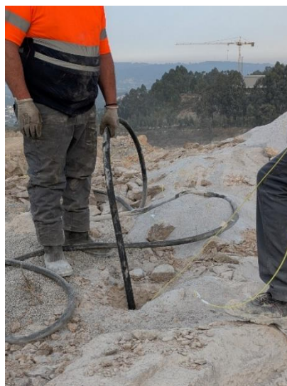
Figura 36- Injeção de mistura explosiva com mangueira específica para o efeito.
