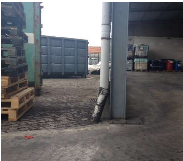
Figura 4.3 – Parque de resíduos perigosos.
