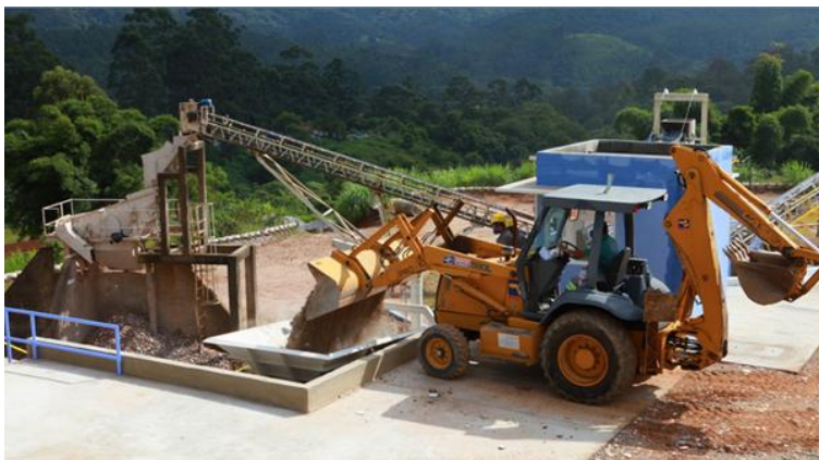
Figura 3.11 – Abastecimento do triturador (Proguaru 2016)
