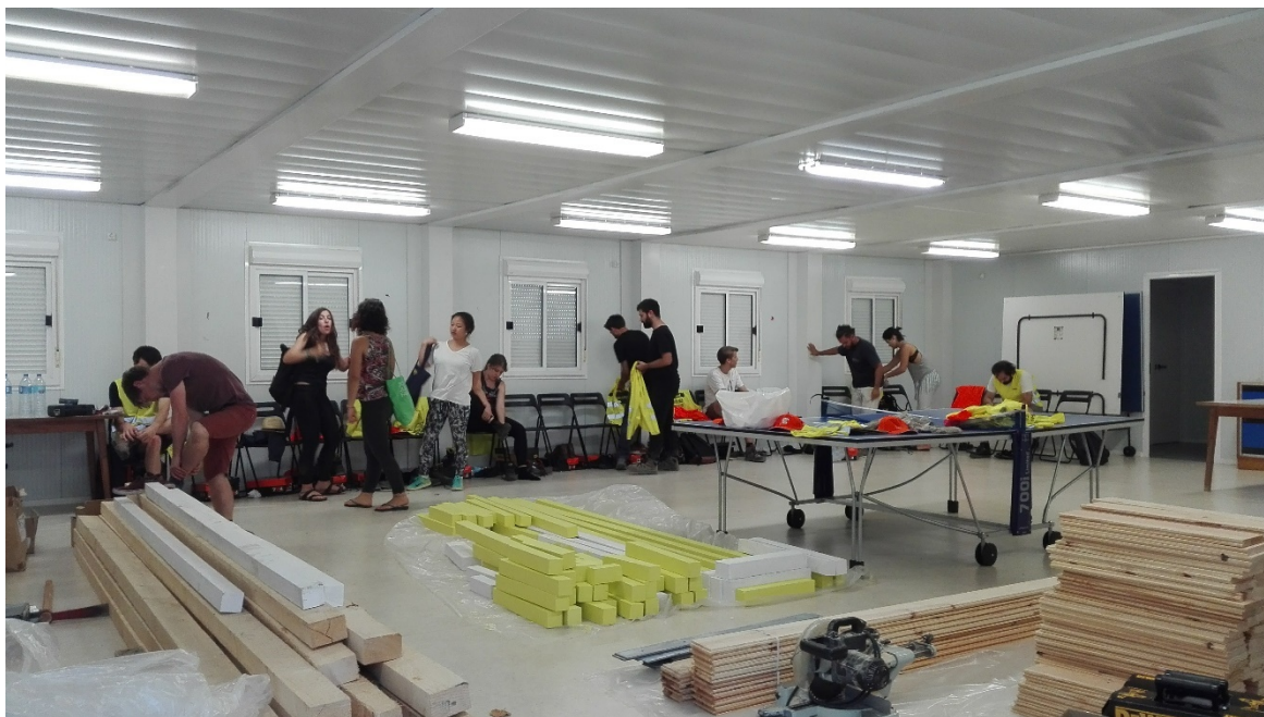
Figura 16 Estaleiro da obra no Espaço Raiz © Casa da Arquitectura
