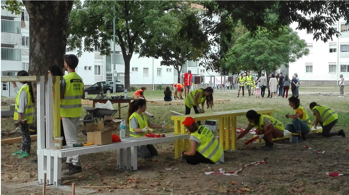
Figura 20 Construção do projeto no Bairro das Campinas © Casa da Arquitectura
