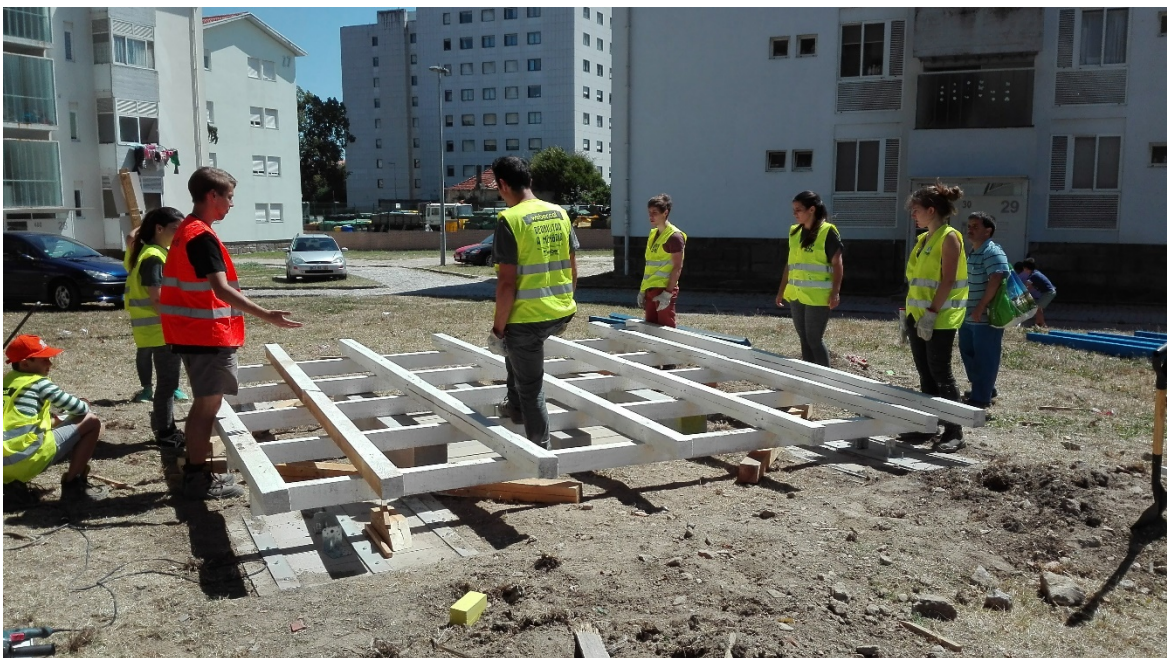
Figura 21 Construção do projeto no Bairro das Campinas © Casa da Arquitectura
