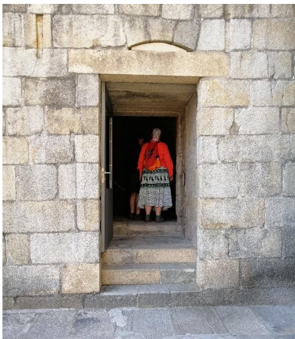
Figura 67: Porta que dá acesso à Torre
