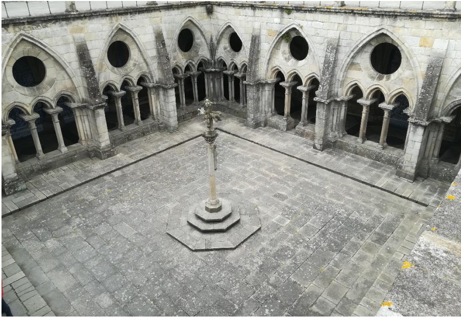
Figura 28: Aspeto geral do Claustro Gótico
