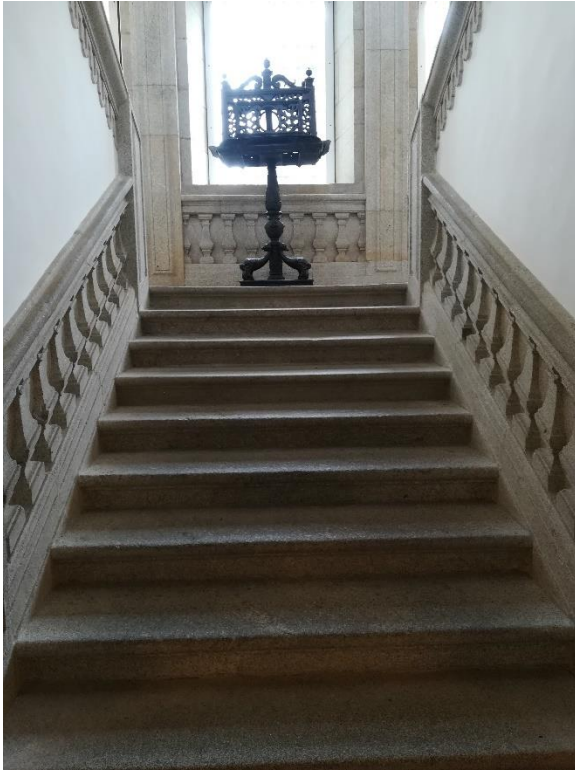
Figura 56: Escada barroca que liga o Claustro Gótico ao Claustro Superior
