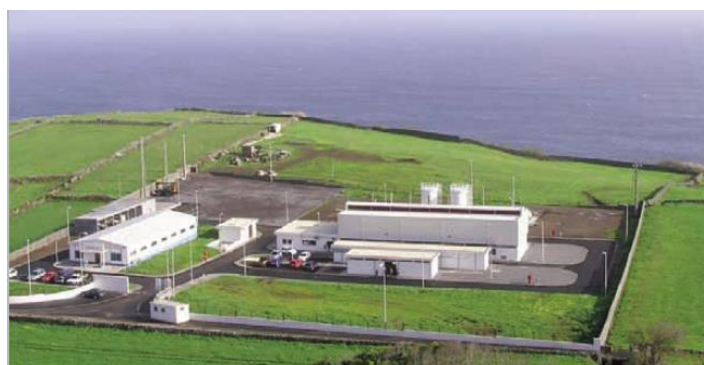
Figura 2.5: Central Termoelétrica da ilha Graciosa
