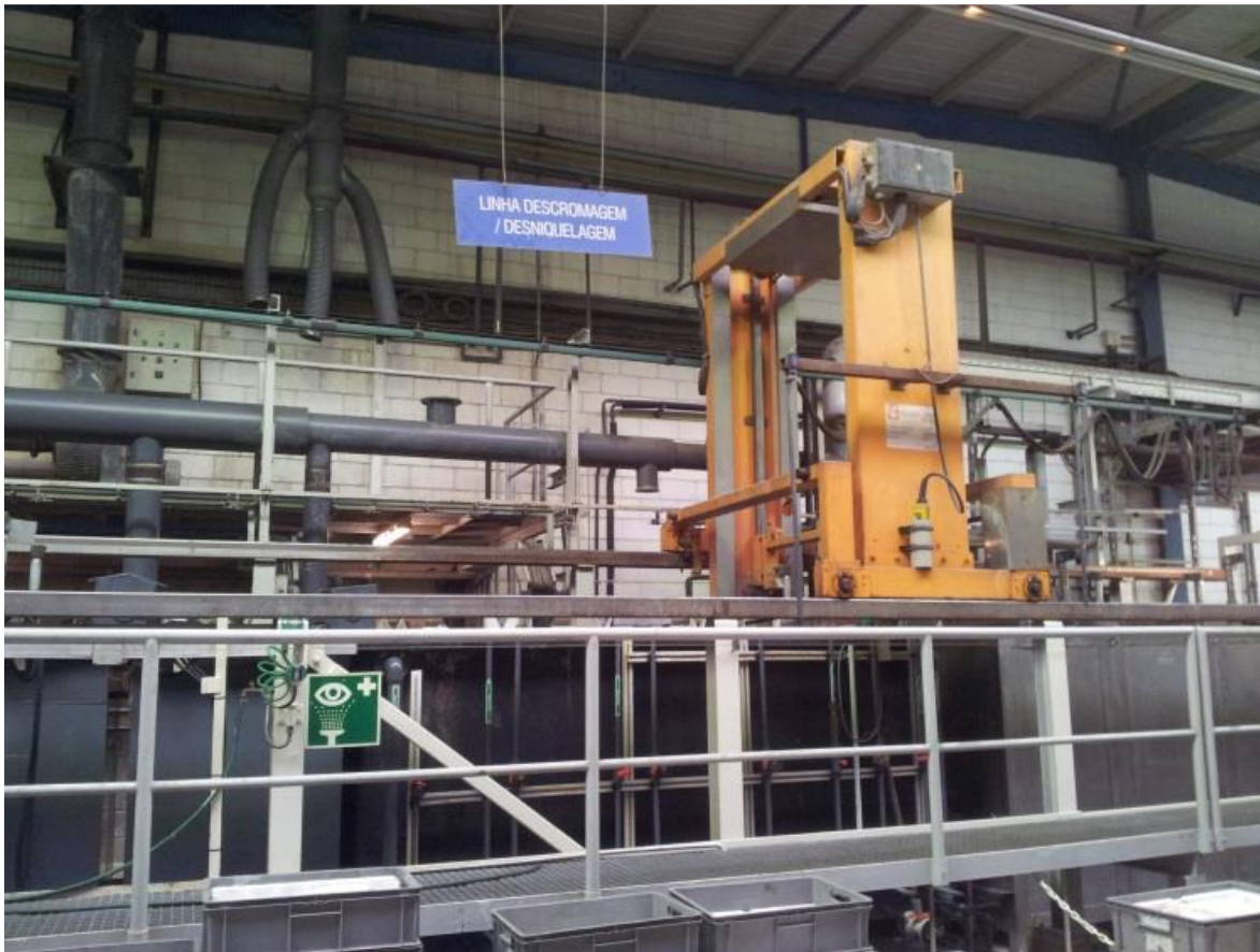
Figura 12 Linha de descromagem e desniquelagem.
