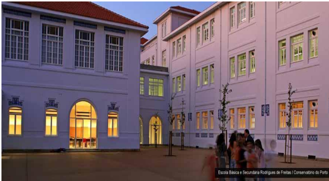
Figura 3. Atuais instalações do Conservatório de Música do Porto
