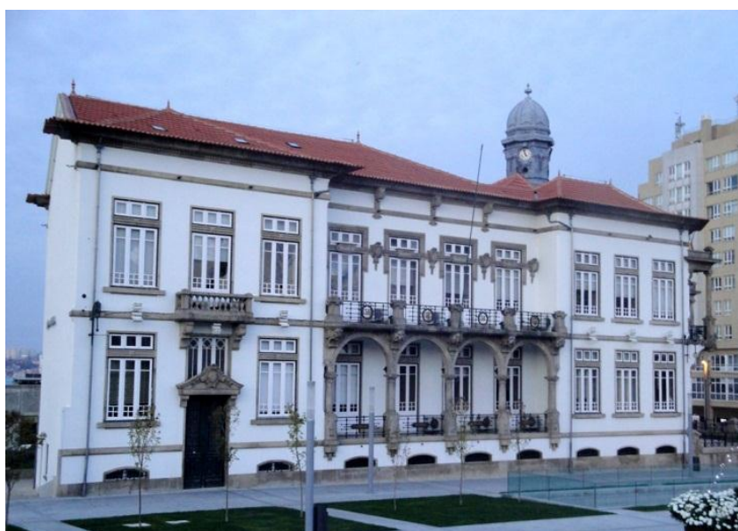
Figura 2.3 - Fachada Sul do Edifício Paços de Concelho.
