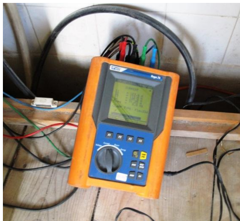
Figura 3.14 - Analisador de energia elétrica ligado.
