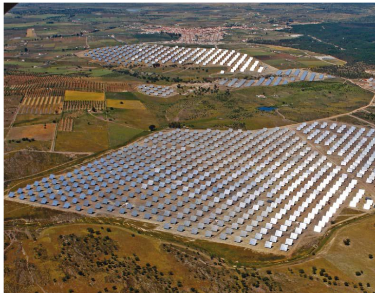
Figura 2 - Seguidores instalados na Central Solar Fotovoltaica
