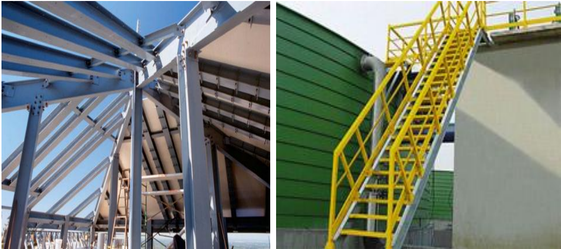
Figura 35 - Estrutura de uma cobertura e escadas de acesso, realizadas em perfis pultrudidos [59, 60]
