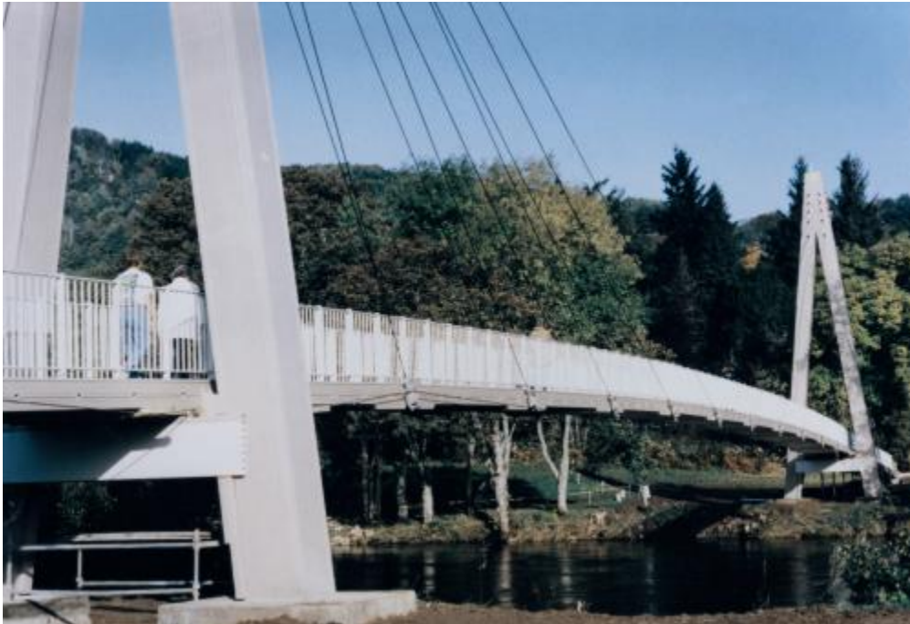
Figura 29 - Ponte de Aberfeldy (Escócia), construída em perfis pultrudidos [33]
