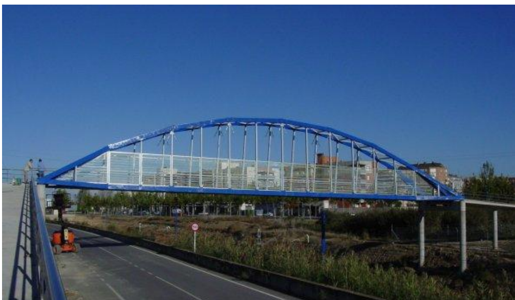
Figura 30 - Ponte de Lérida (Espanha) totalmente construída em perfis pultrudidos [68]
