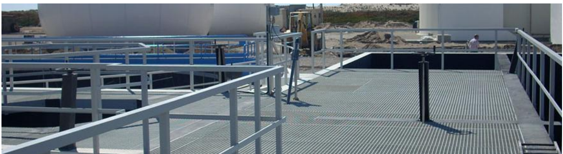
Figura 33 - Aplicação de perfis pultrudidos e gradil numa ETAR [46].
