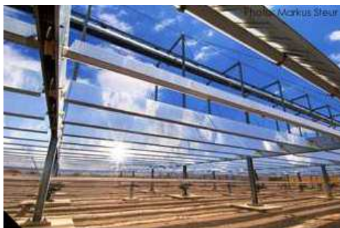
Figura 74 Esquema de concentrador Fresnel linear [42] [43]
