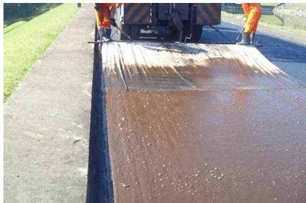
Figura 3.21 – Aplicação de Lama Asfáltica (Pavimentar, 2016)
