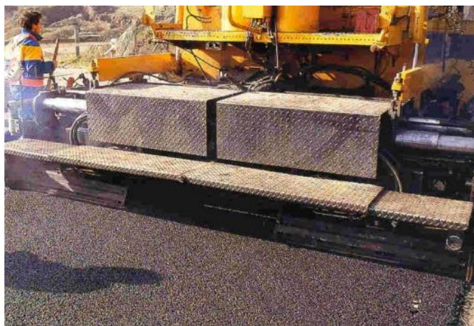
Figura 3.22 – Microbetão Betuminoso Rugoso (Sanestradas, 2016)
