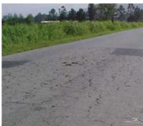
Figura 3.12 – Fissuras de retração do betão [9]
