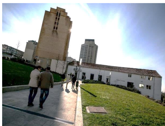
Figura 2.4 – Edifício dos Serviços Técnicos da CMVNG
