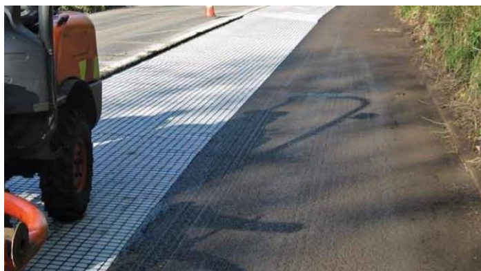
Figura 3.24 – Aplicação de Geogrelhas ou Grelhas de Reforço (Tensal, 2016)
