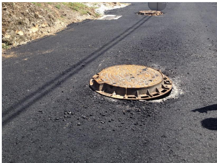
Figura 4.26 – Nivelamento de tampas de câmaras de visita
