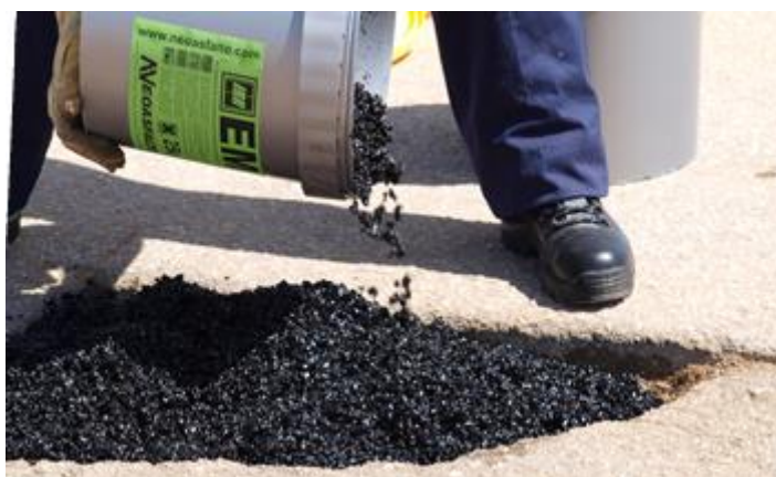
Figura 3.20 – Micro aglomerado betuminoso a frio (Neoasfalto, 2016)
