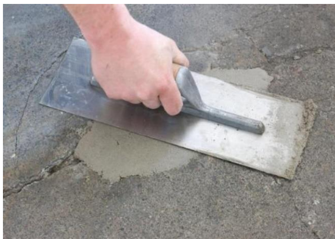
Figura 3.26 – Tratamento de fissuras superficiais
