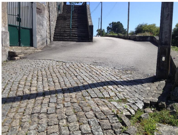
Figura 4.35 – Rampa de acesso à igreja
