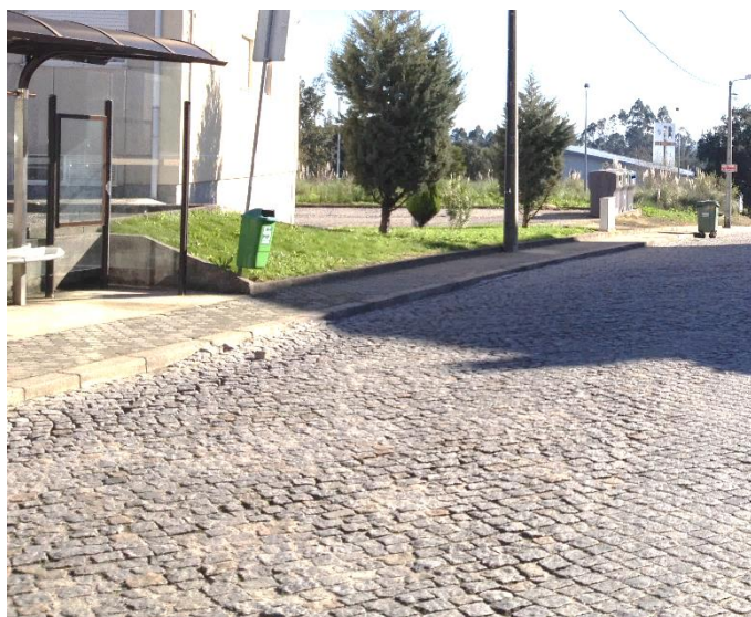
Figura 4.19 – Faixa de rodagem existente da Rua Heróis do Ultramar - Rodeiras
