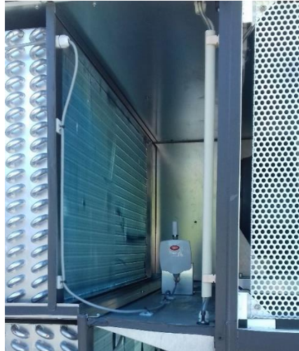
Figura 20 - Exemplo sensor de temperatura e humidade relativa do ar, marca Carel (registro fotográfico).
