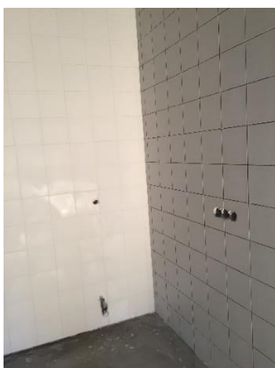
Figura 3.16 – Parede com acabamento em cerâmico
