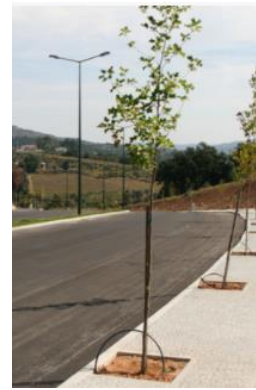
c) Aspeto após pavimentação
