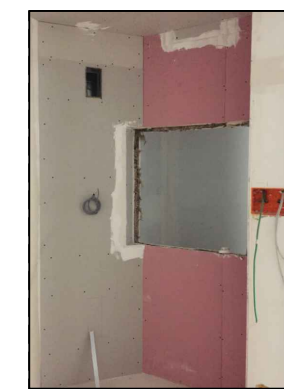
Parede em gesso cartonado
