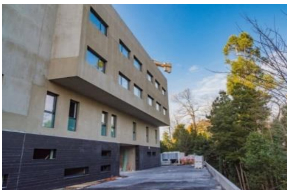
Figura 3.15 – Fachada com acabamento em cerâmico (Gomes, 2016)
