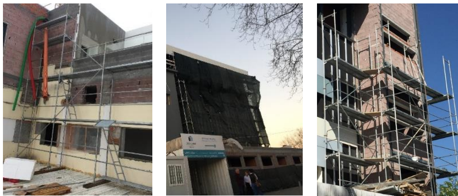
a) Andaime para pequenas alturas
