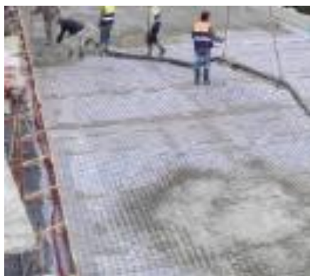
Figura 3.18 – Aplicação de betão nos pavimentos (Gomes, 2016)
