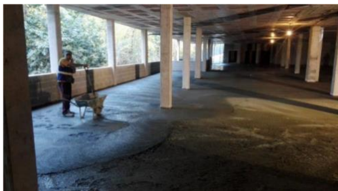
Figura 3.19 – Aplicação do endurecedor nos pavimentos em betão (Gomes, 2016)
