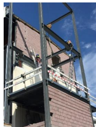
c) Construção de parede de alvenaria
