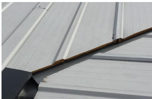
Figura 3.12 – Cobertura inclinado com painel sandwich
