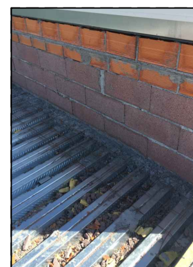
Laje de cobertura da estrutura metálica
