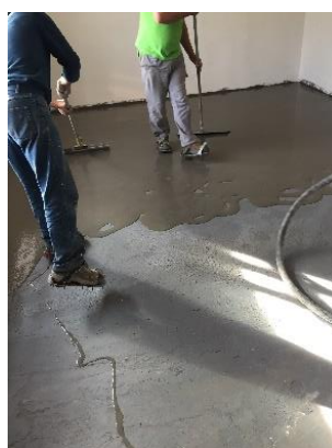
c) Aplicação do autonivelante
