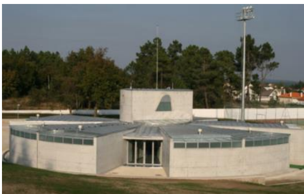
a) Edifício dos balneários com cobertura plana
