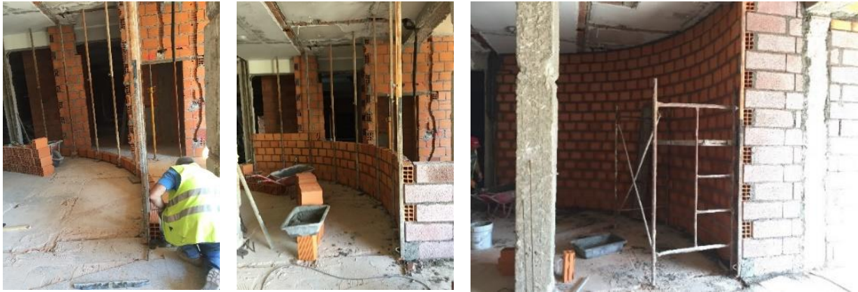
a) Aplicação da primeira camada b) Construção da parede por camadas c) Aspetto final da parede de alvenaria de tijolo cerâmico
