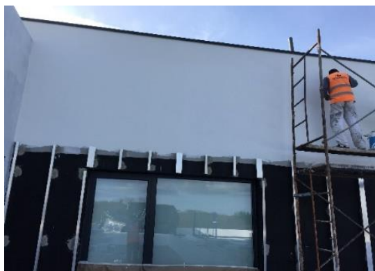
Figura 3.14 – Fachada com acabamento em areado fino
