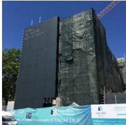
b) Parte do aspeto final da estrutura metálica revestida
