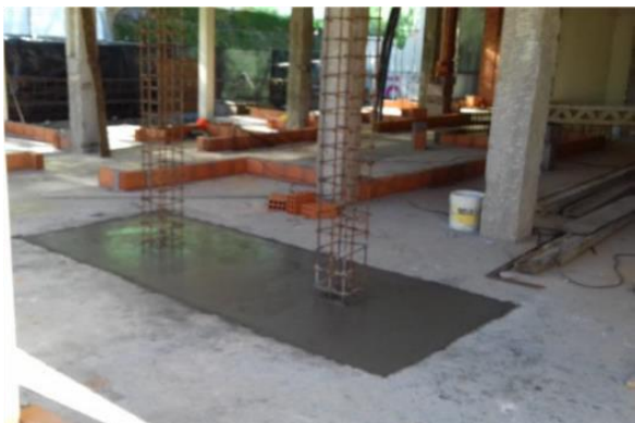
Figura 3.10 – Alvenaria de tijolo cerâmico (Gomes, 2016)
