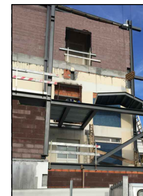
Construção da escadas metálica
