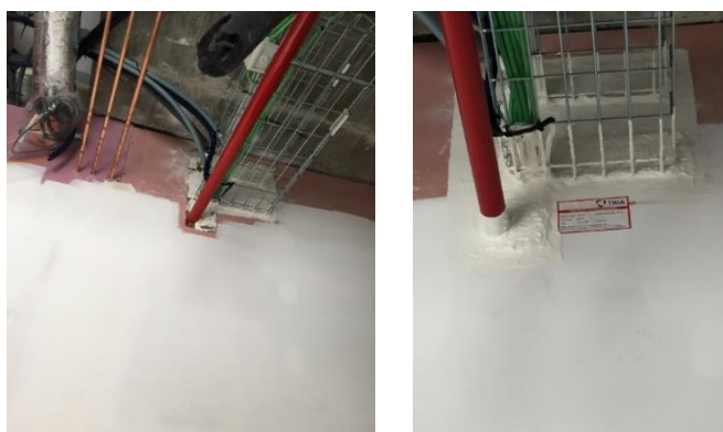
a) Aspeto das infraestruturas antes da selagem
