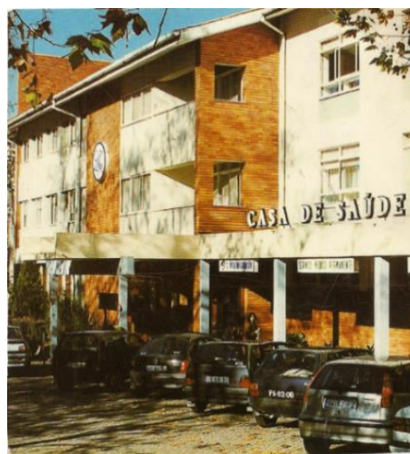
b) Fachada CSSM antes da intervenção (Chaves, 2014)
