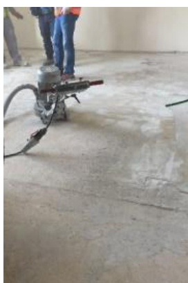
a) Arranque das colas do pavimento
