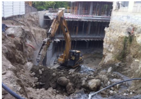
Figura 3.8 – Escavação de terras (Gomes, 2016)
