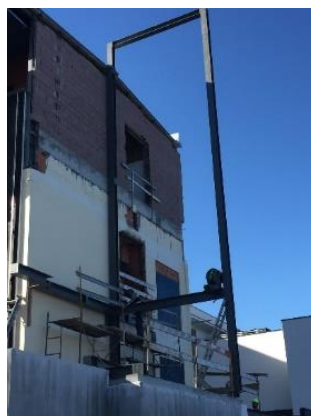
b) Colocação dos pilares de travamento
