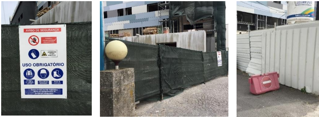
a) Sinalização espaço de estaleiro
