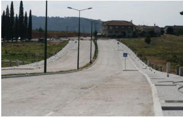
a) Preparação para pavimentação da circular
