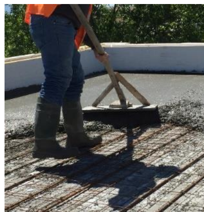
c) Alisamento da calda de betão
