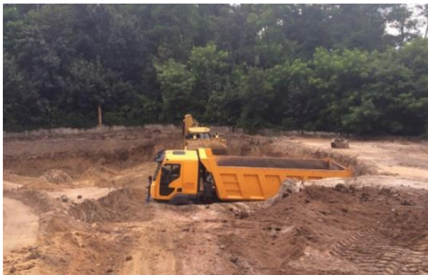
Figura 3.7 – Transporte de solos para aterro (Gomes, 2016)
