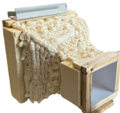
Figura 29 - Fixação das placas de poliuretano e aplicação da espuma expansiva.
