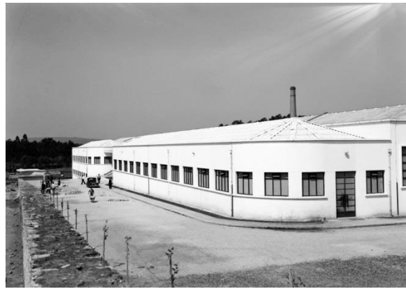
Figura 1.2 - Continental - Indústria Têxtil do Ave (fachada da cantina e dos recursos humanos) [Leite, 2013].
