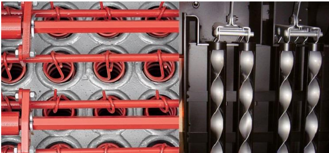
Figura 23 - Métodos mecânicos da limpeza do permutador de uma caldeira | Fonte: [34]
