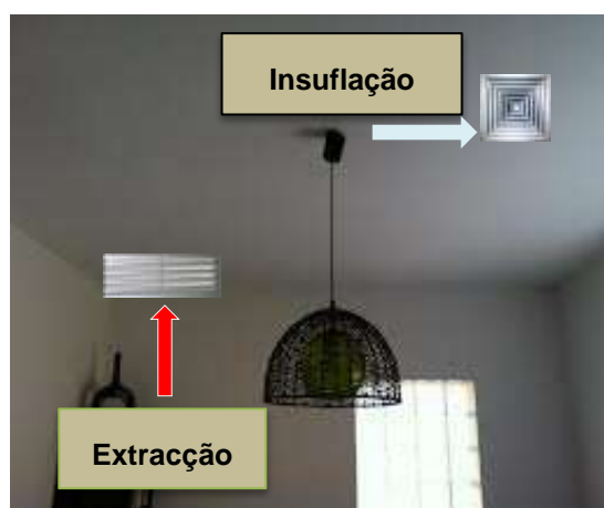
Figura 10 Insuflação e extracção distanciadas; eficiência de 70%
