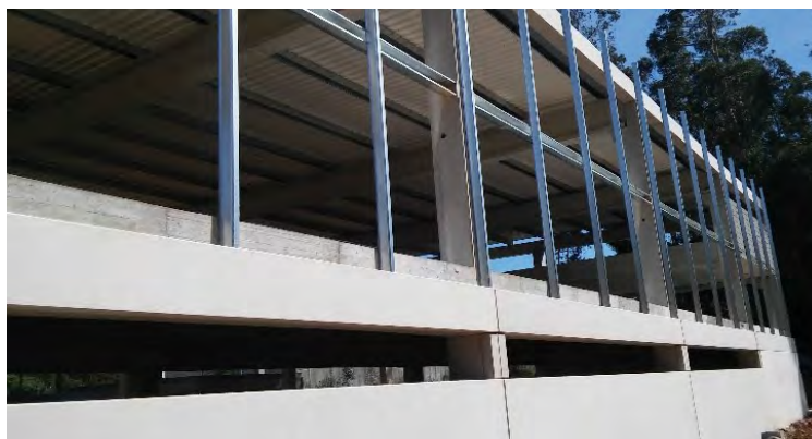
Figura 6.41 – Perfis dispostos na fachada exterior.
