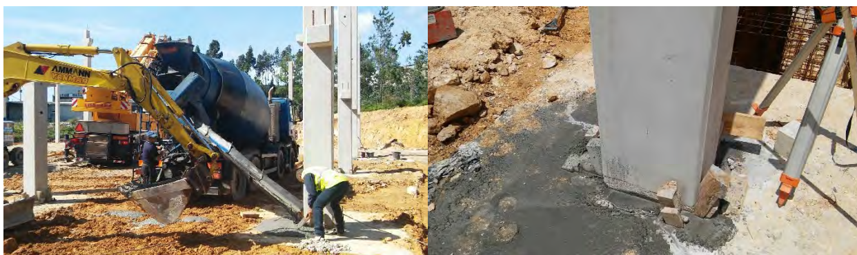
a) Betonagem direta do reservatório para a base do pilar.
