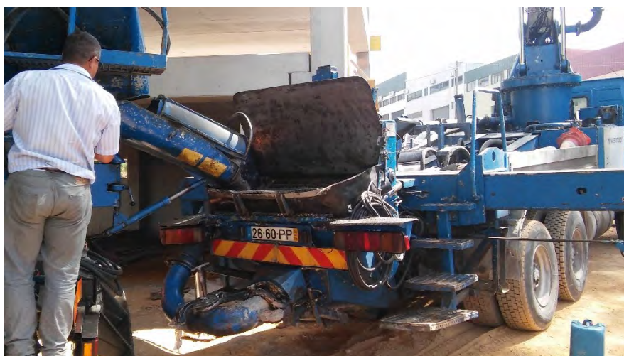
Figura 6.34 – Passagem do betão entre camiões.
