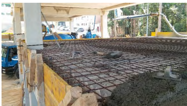
a) Colocação do betão na laje.
