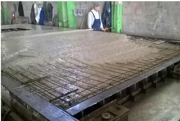
c) Betonagem do painel pré-fabricado
