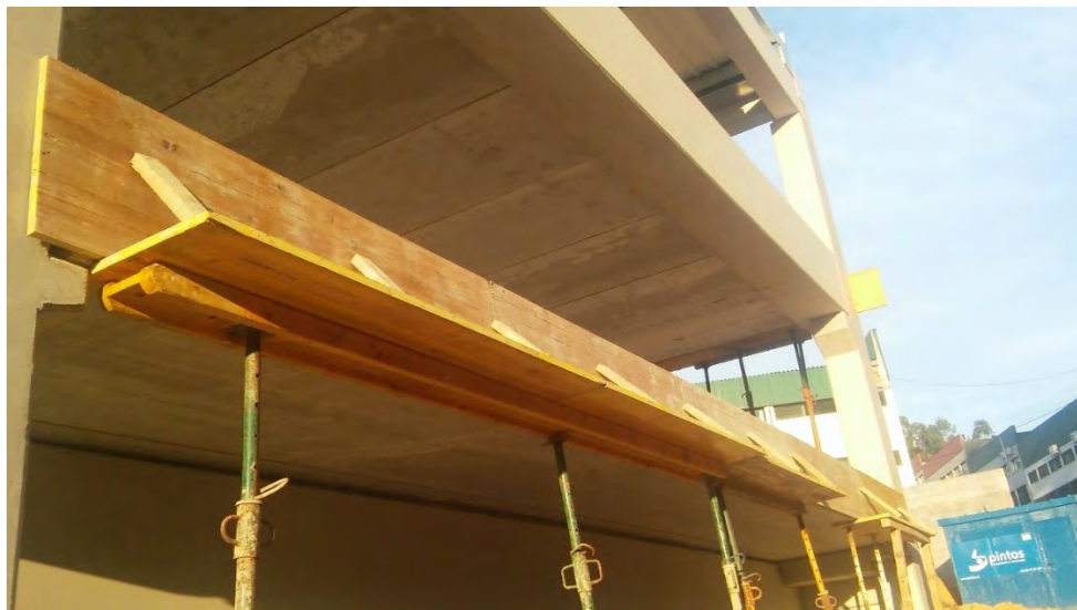
Figura 6.31 – Elementos de cofragens.
