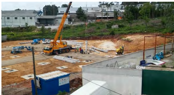
Figura 6.14 – Colocação do primeiro pilar na obra.
