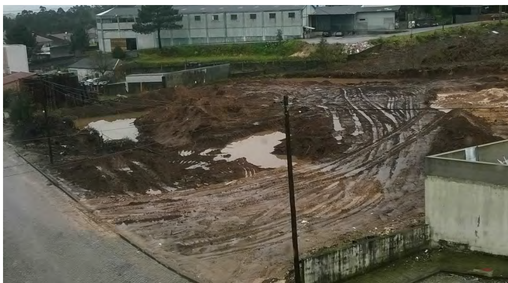
Figura 6.4 – Decapagem do local da obra.
