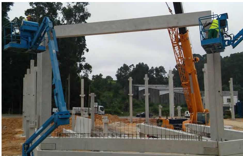
Figura 6.23 – Colocação das vigas principais.
