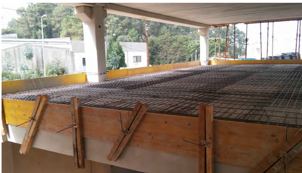
Figura 6.32 – Armadura negativa colocada nas lajes alveolares.
