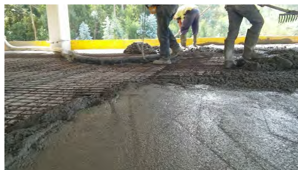
b) Espalhamento do betão na laje.
