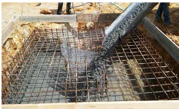
a) Betonagem da sapata com betão pronto.
