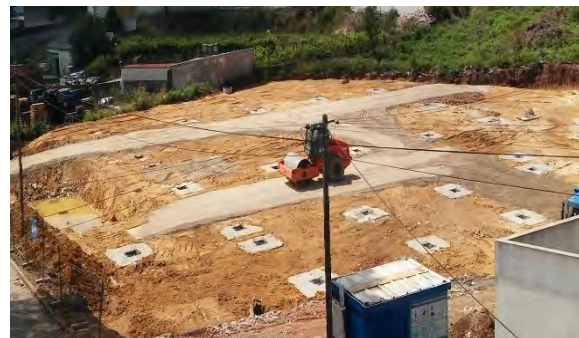
b) Passagem do cilindro para compactação da camada de tout-venant.
