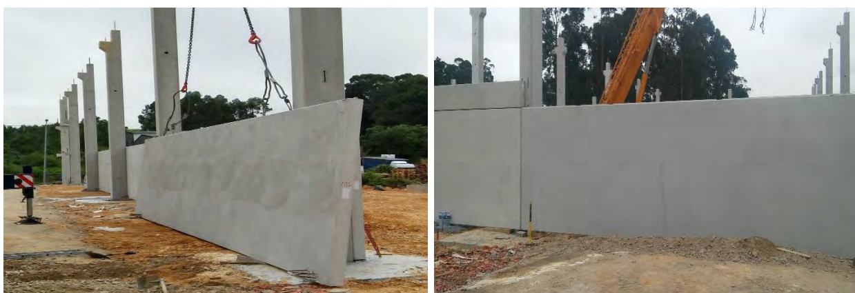
a) Pormenor relativo à elevação dos painéis.
