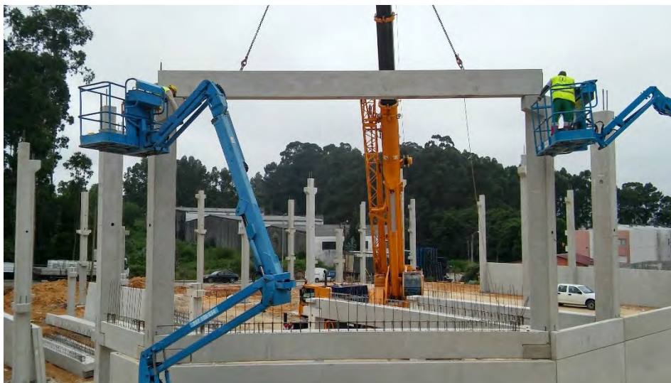
Figura 3.2 – Exemplo de gruas com braços extensíveis para montagem de viga da cobertura.
