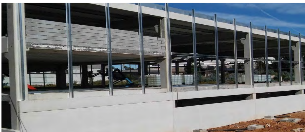
Figura 6.38 – Construção das paredes de alvenaria em blocos de betão.
