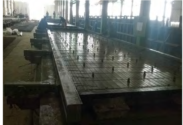
b) Colocação da armadura do painel pré-fabricado a ser executado
