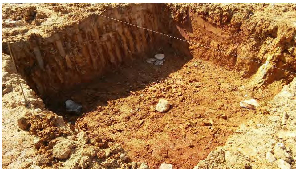
Figura 6.8 – Exemplo de abertura de caboucos.
