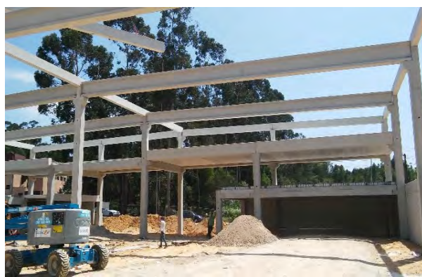
b) Exemplo de construção de um edifício recorrendo à construção pré-fabricada
