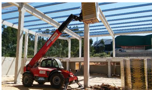
f) Colocação da lâã de rocha na cobertura.
