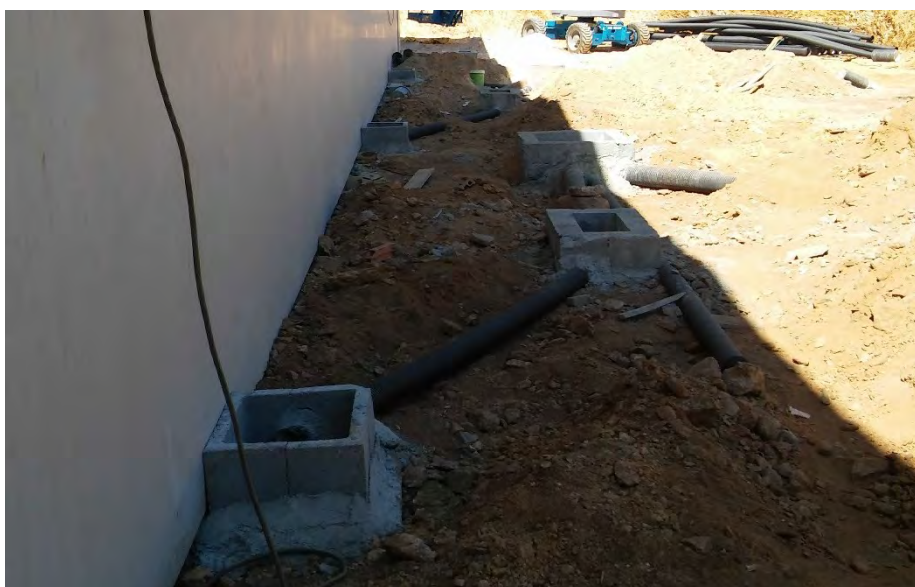
Figura 7.2 – Caixas e respetivos tubos de drenagem de água pluviais.
