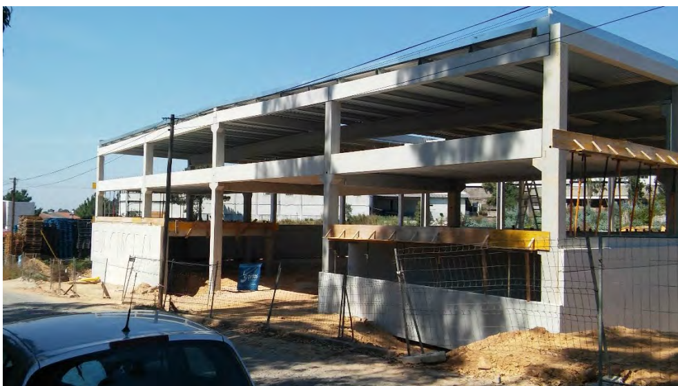
Figura 6.30 – Cofragem das lajes alveolares.
