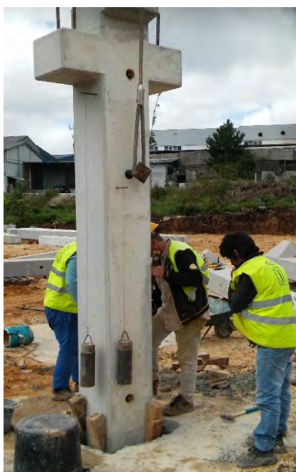
a) Utilização de cunhas e níveis para posicionar o pilar mais pequeno.
