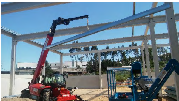
a) Perfis metálicos de suporte da cobertura.
