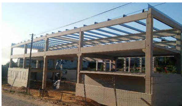
c) Disposição dos perfis metálicos ao longo do pavilhão.
