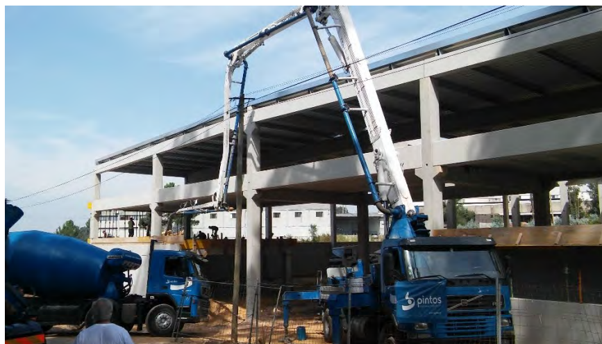
Figura 6.35 – Bombagem do betão para as lajes alveolares.
