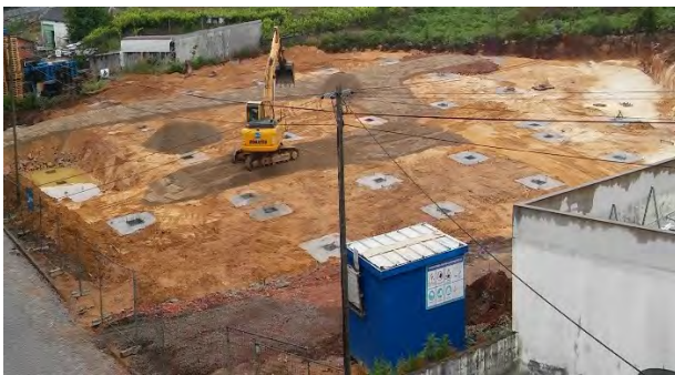
a) Colocação da camada de tout-venant para circulação de máquinas.
