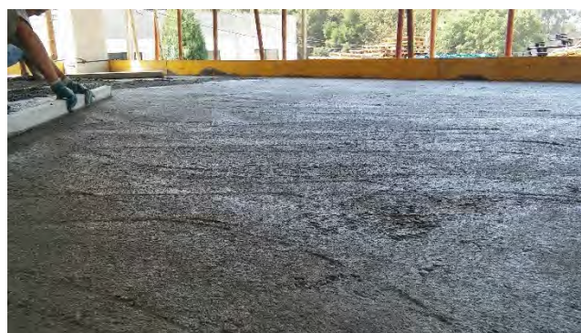
c) Compactação do betão.
