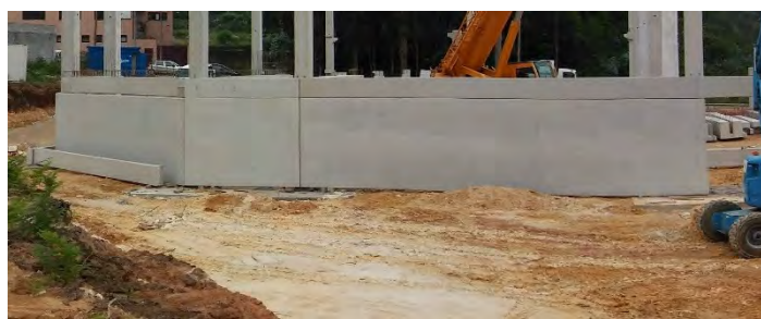
e) Disposição construtiva dos painéis já no local final.
