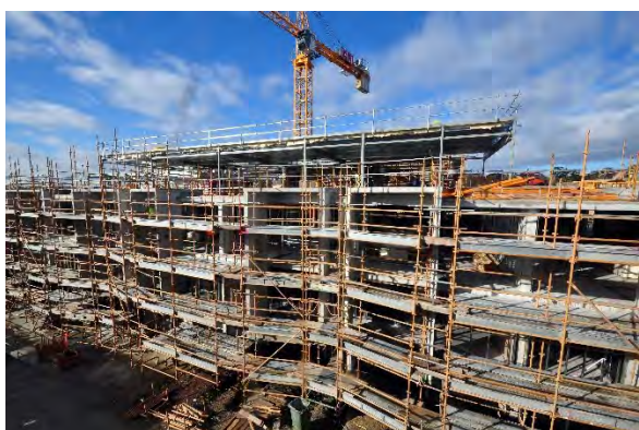
a) Exemplo de construção de um edifício recorrendo à construção tradicional
