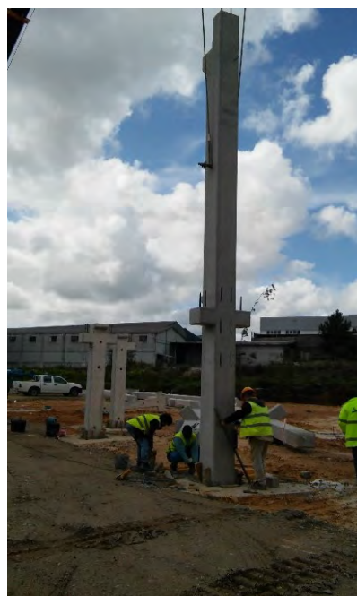
b) Utilização de cunhas e níveis para posicionar o pilar maior.
