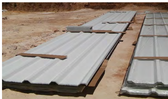
d) Chapas metálicas da cobertura.
