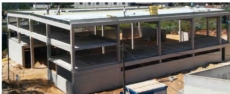
h) Aplicação da lã de rocha e da tela em pvc na cobertura.
