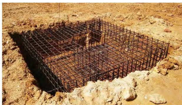
Figura 6.9 – Colocação das armaduras das sapatas nos caboucos.
