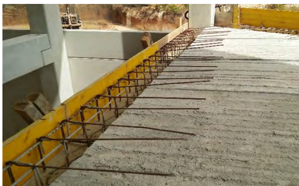
a) Armadura proveniente das vigas.
