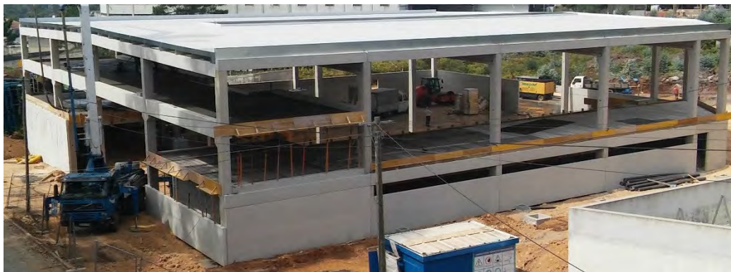
Figura 6.37 – Regularização da laje de betão.
