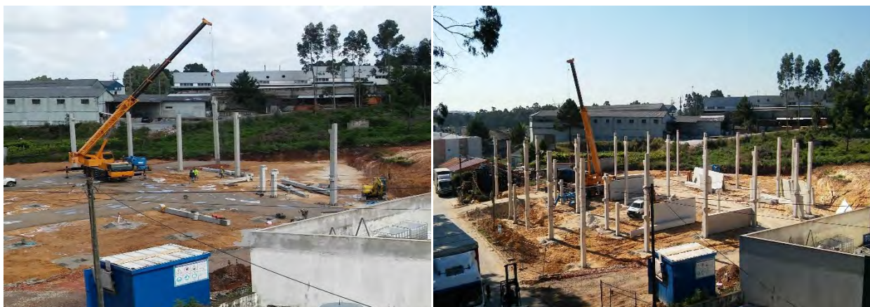
a) Fase intermedia da colocação dos pilares.
