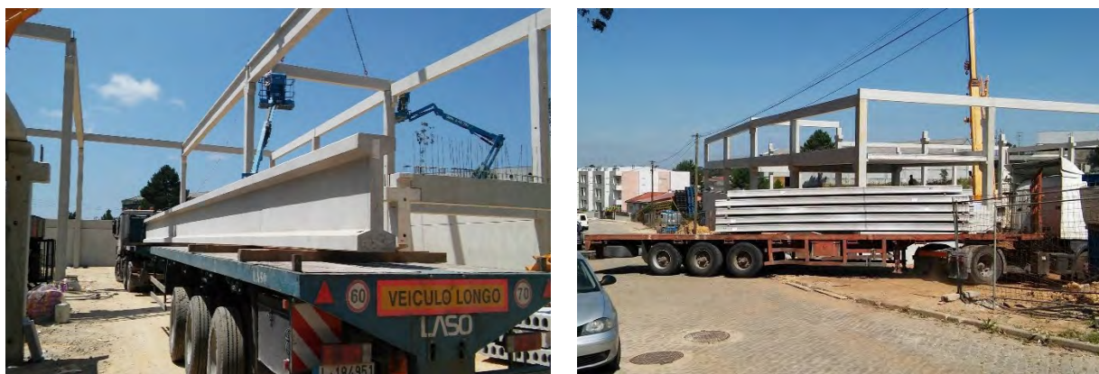
a) Camião de transporte de vigas
