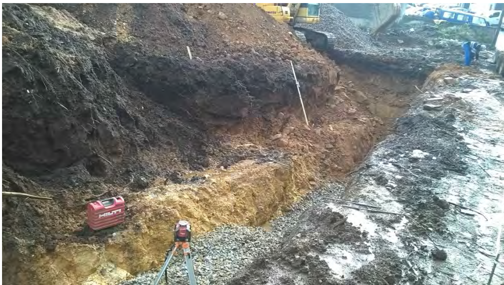
Figura 6.5 – Abertura de vala para instalação de tubo drenante.
