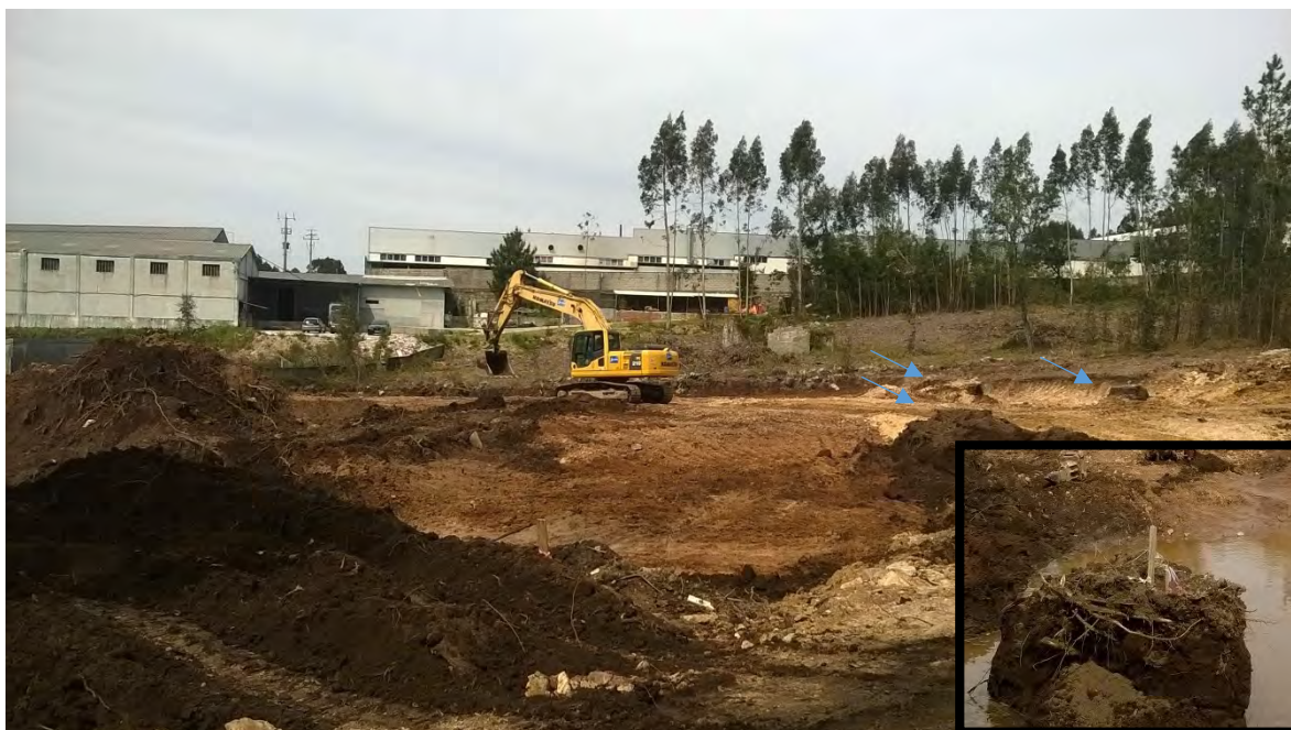
Figura 6.7 – Trabalho de escavação e respetivos marcos de localização do edifício.
