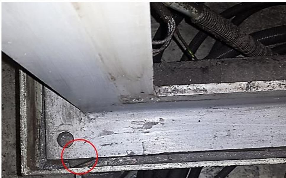
Figura 182 – Zonas da máquina onde persistem alguns calços de borracha, embora a posição destes tenha sido alterada com a vibração sofrida pelo equipamento.
