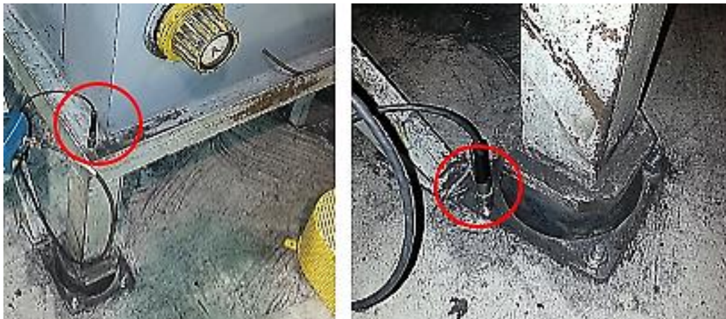
Figura 186 – Terceiro ponto de medição, situado na estrutura de suporte da máquina (à esquerda) e o quarto ponto de medição, localizado junto à base de suporte do elemento anti vibrátil (à direita).
