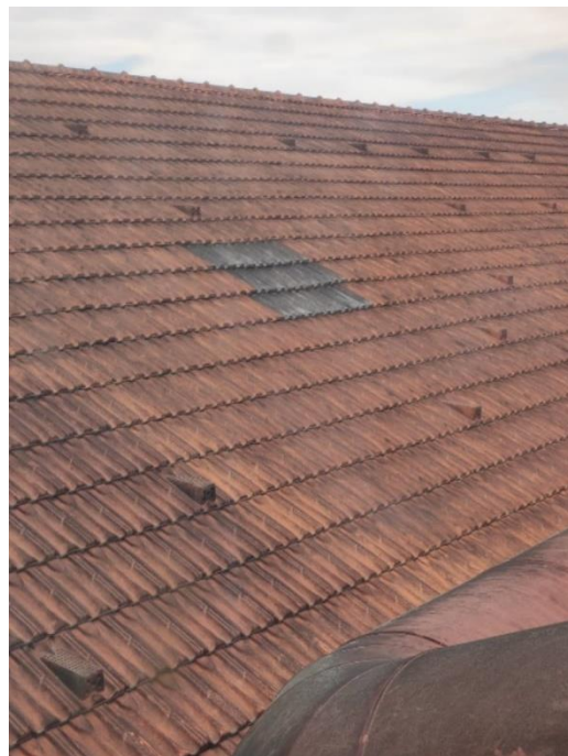
Figura 4.12 - Revestimento em telha cerâmica – cobertura Armazém D
