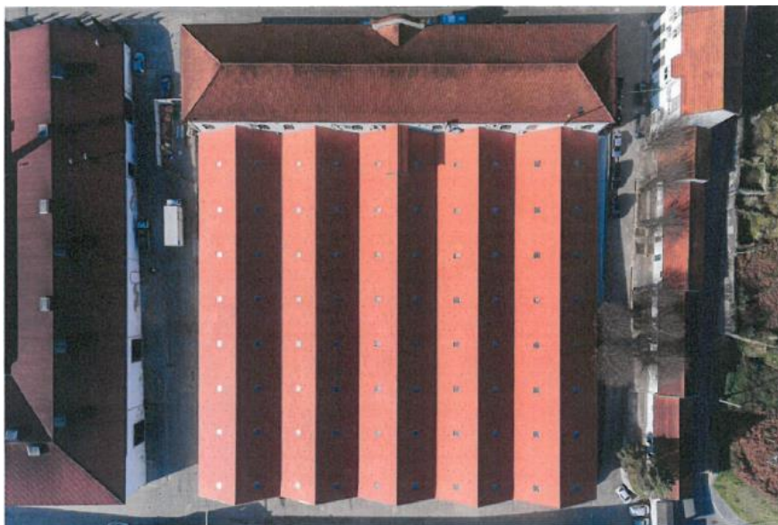
Figura 4.3 - Foto da vista superior das coberturas do armazém D.
