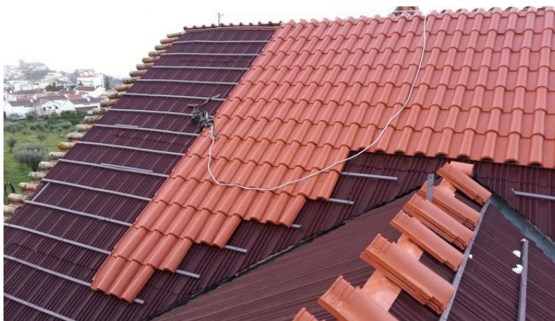
Figura 3.15 - Aplicação de subtelha. Fonte: https://pt.onduline.com/pt-pt/particulares/produtos/825/subtelha-st150 (21 de julho de 2022)
