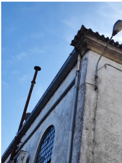
Figura 4.21 – Caleira e tubo de queda
