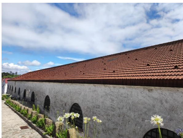
Figura 4.10 – Cobertura Armazém D
