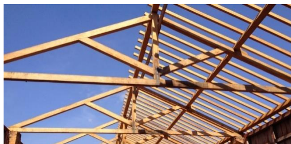
Figura 3.5 - Estrutura de madeira. Fonte:
