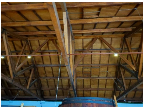
Figura 4.15 – Elementos da cobertura, vista pelo interior
