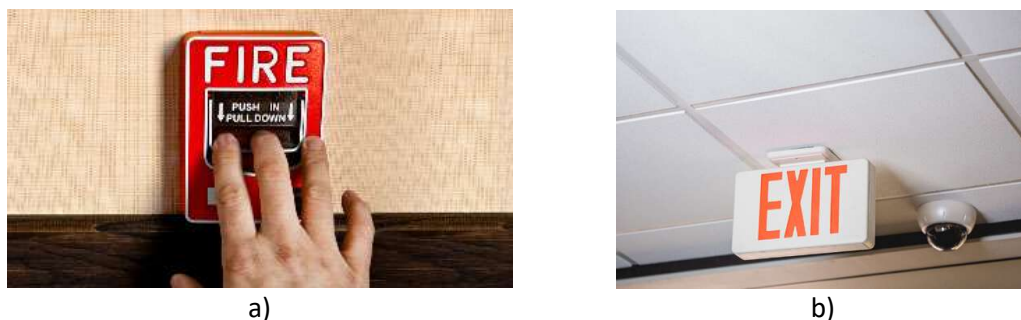
Figura 4 - Sistemas ativos de proteção: a) Dispositivo de alarme, b) Luz de emergência de saída [19].
