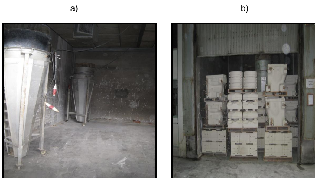
Figura 6 – Estufa 1: a) vazia; b) carregada com moldes e pronta para a secagem
