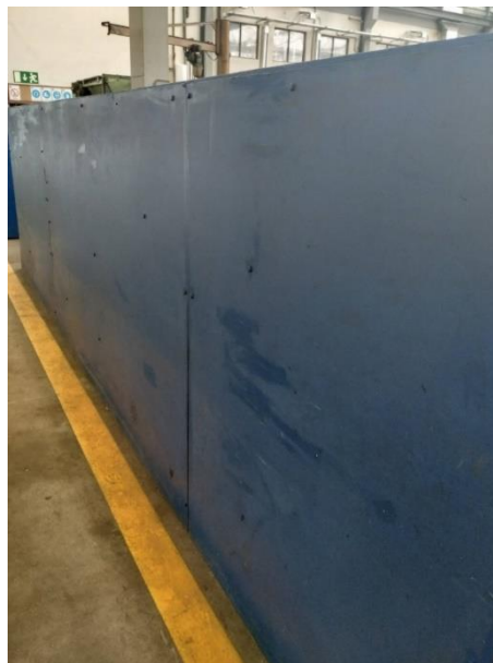
Figura 35 - Reparação e pintura dos painéis laterais do armário.
