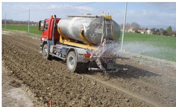
Figura 22 – Regulação do teor em água com recurso a um camião cisterna (LCPC/SETRA, 1992).
