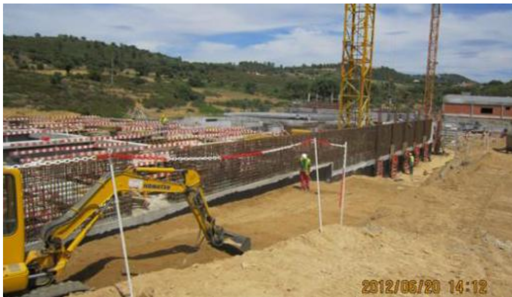
Figura 30 – Execução do aterro para um dos tanques de arejamento.
