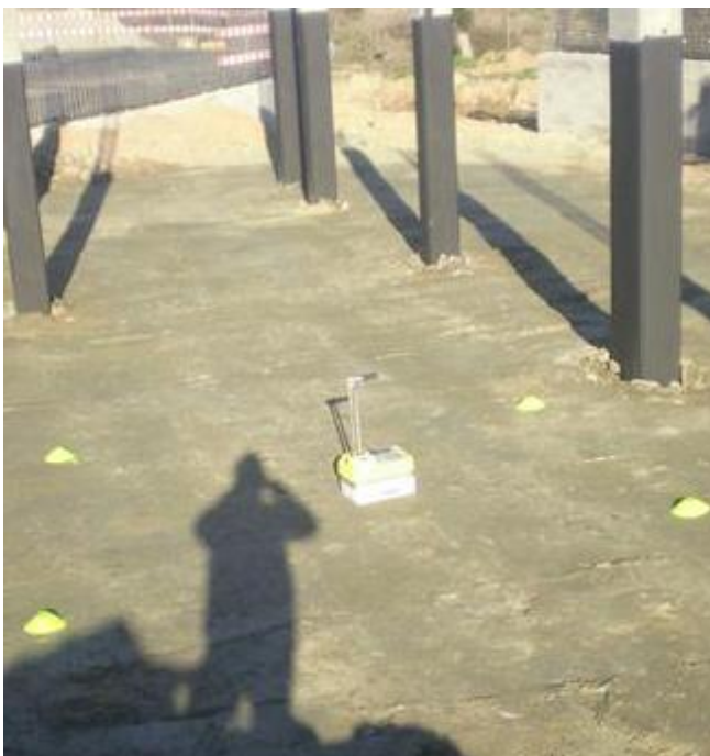
Figura 26 – Equipamento Troxler a efetuar controlo da compactação em obra.
