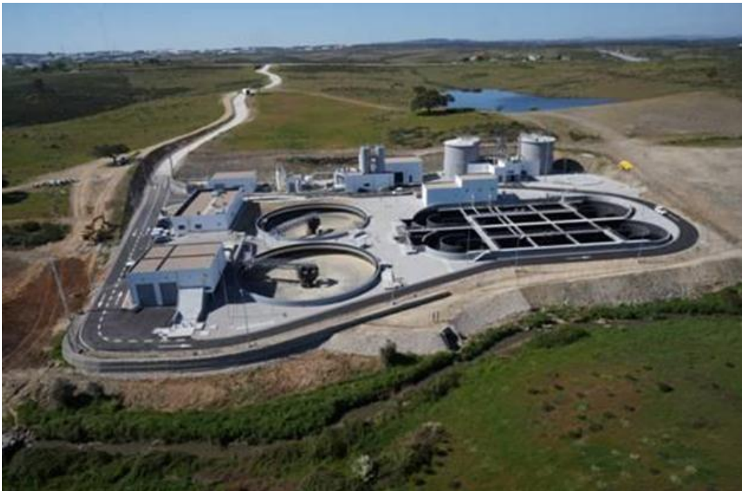
Figura 29 – ETAR de Castelo Branco (Mota-Engil & Águas do Centro, 2012).
