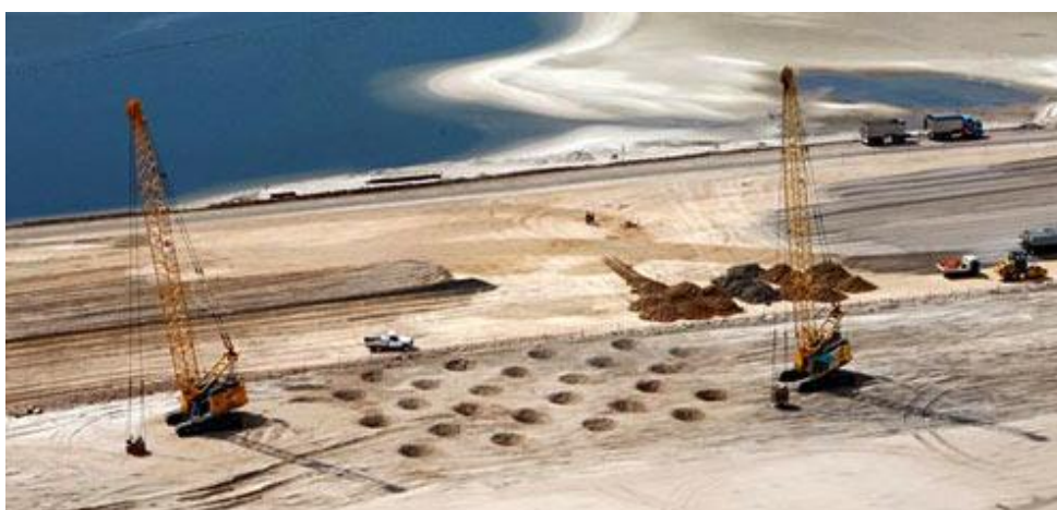
Figura 25 - Compactação dinâmica de área extensa ( http://www.menardbachy.com.au/dynamic_compaction.php ).
