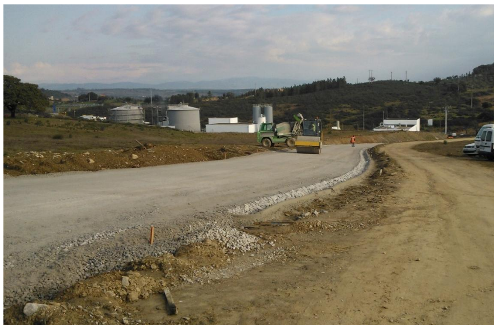
Figura 31 – Compactação da camada de agregado da via de acesso à ETAR.
