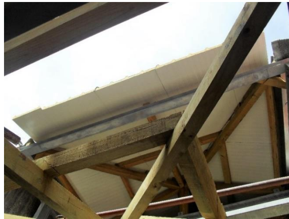
Figura 5.42 – Construção da cobertura
