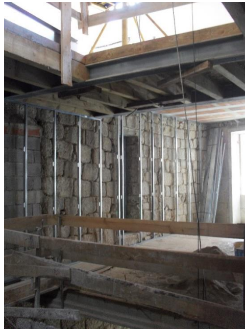
Figura 5.9 – Montagem da estrutura para aplicação de placas de gesso cartonado
