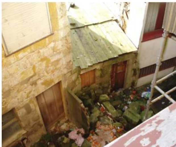
b) Fachada do tardoaz antes das demolições (Fonte: Porto Vivo, SRU)
