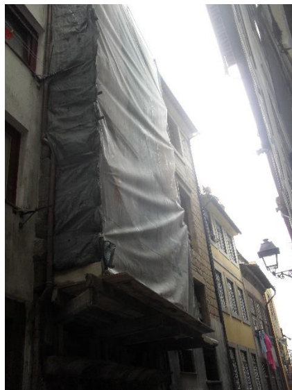
Figura 5.30 – Fachada frontal durante processo de tratamento da parede
