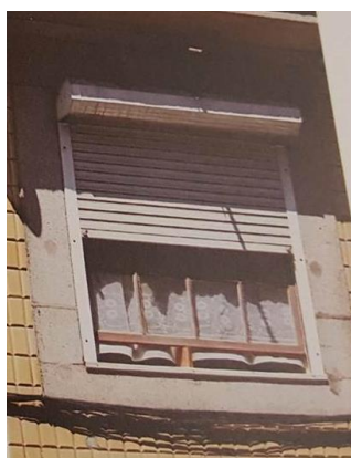
Figura 4.9 – Vão envidraçado de caixilharia de madeira com proteção exterior e vidro simples [6]
