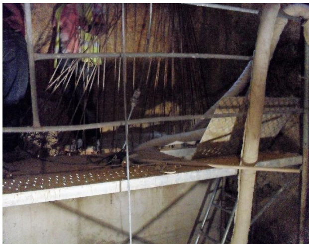
a) Limpeza do morro e início da construção da parede de suporte no piso 1
