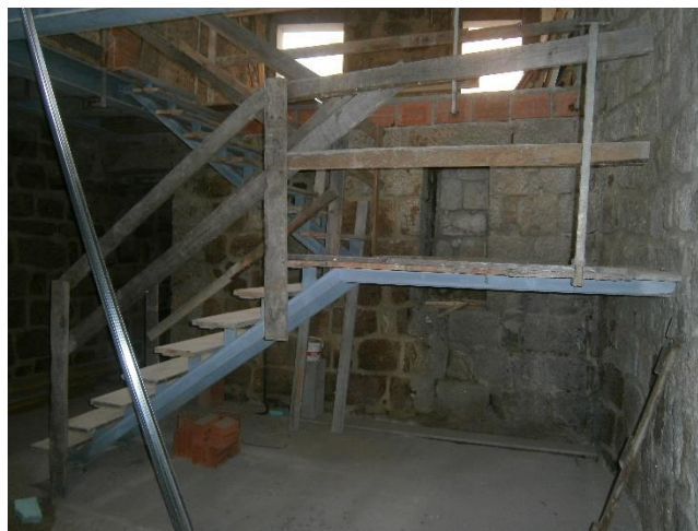
Figura 5.18 – Escadas entre piso 4 e 5
