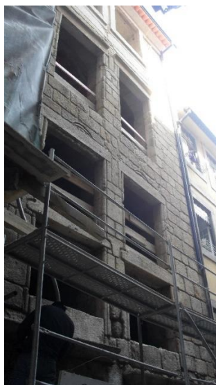
Figura 4.2 – Parede exterior de alvenaria de pedra
