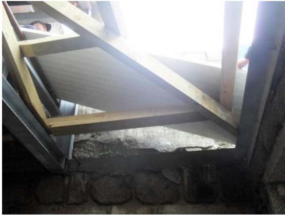
a) Colocação do painel
