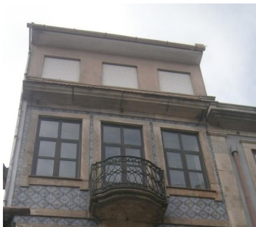
Figura 4.4 – Parede exterior de alvenaria de tijolo no último piso
