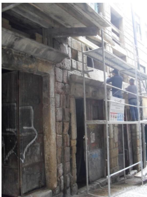
a) Picagem da alvenaria de granito
