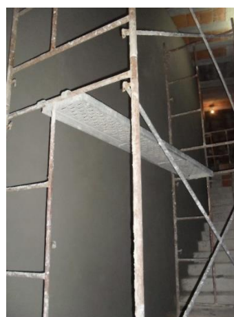
b) Fase de secagem do reboco
