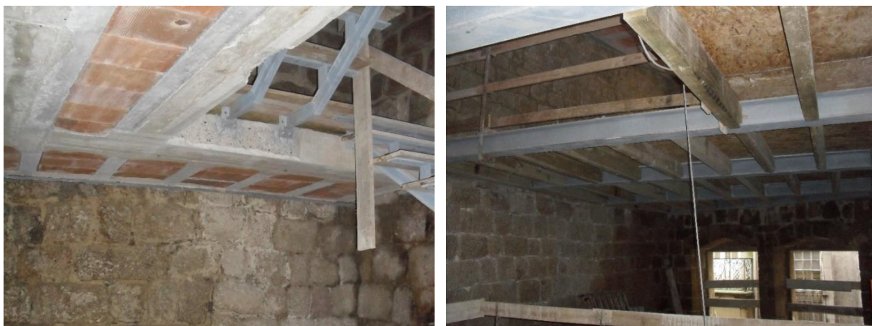
a) Laje do piso 2
