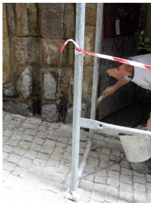
b) Limpeza da alvenaria de granito
