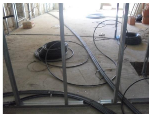
b) Montagem da estrutura para aplicação de placas de gesso cartonado (pormenor pavimento)
