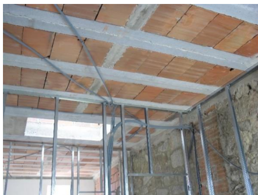
a) Montagem da estrutura para aplicação de placas de gesso cartonado (pormenor teto)
