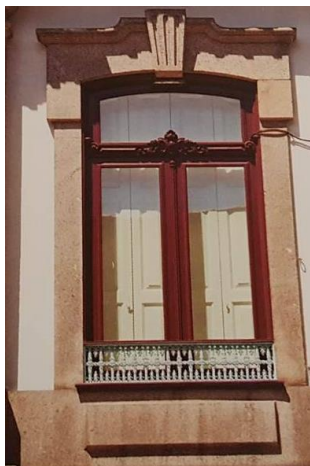
Figura 4.8 – Vão envidraçado de caixilharia de madeira com proteção interior e vidro simples [6]
