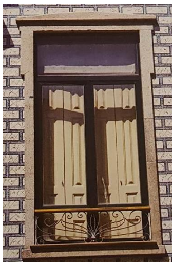
Figura 4.11 – Vão envidraçado de caixilharia metálica com proteção interior e vidro simples [6]
