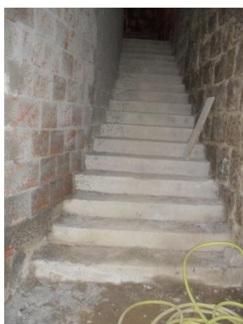
a) Aplicação do reboco
