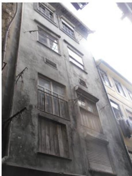
a) Fachada frontal antes das demolições (Fonte: Porto Vivo, SRU)
