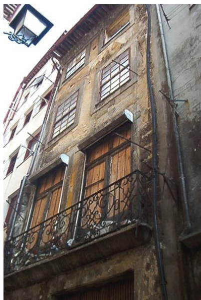
a) Fachada frontal antes das demolições (Fonte: Porto Vivo, SRU)
