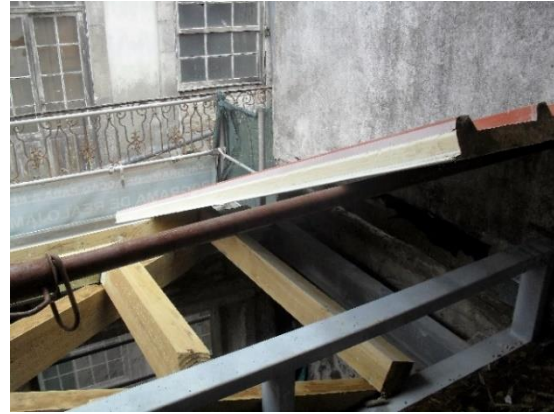
b) Estrutura da cobertura
