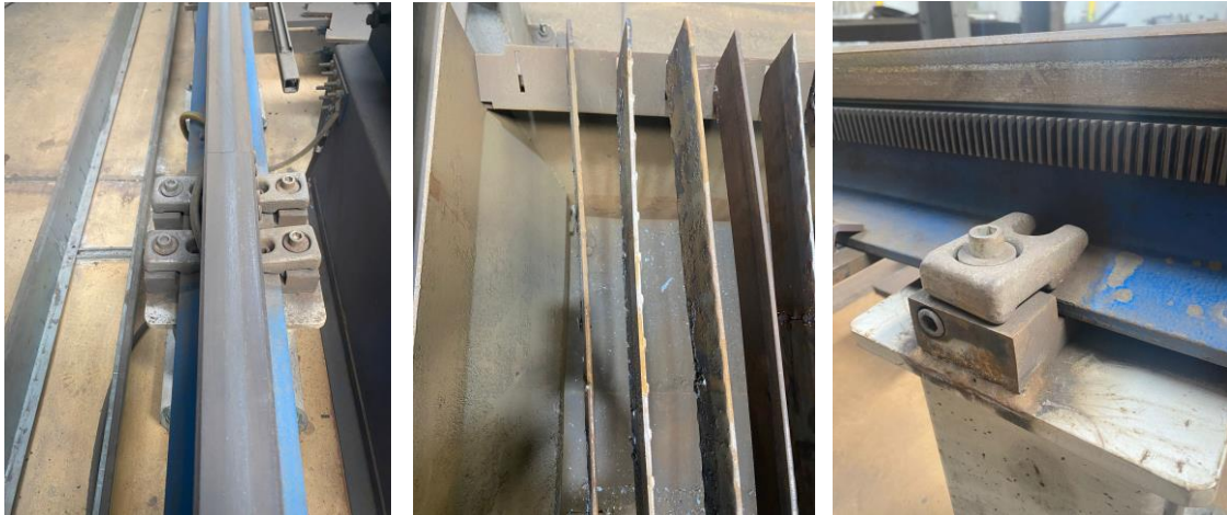
Figura 56- Depois da implementação da Manutenção Autónoma no EQP06 (b)
