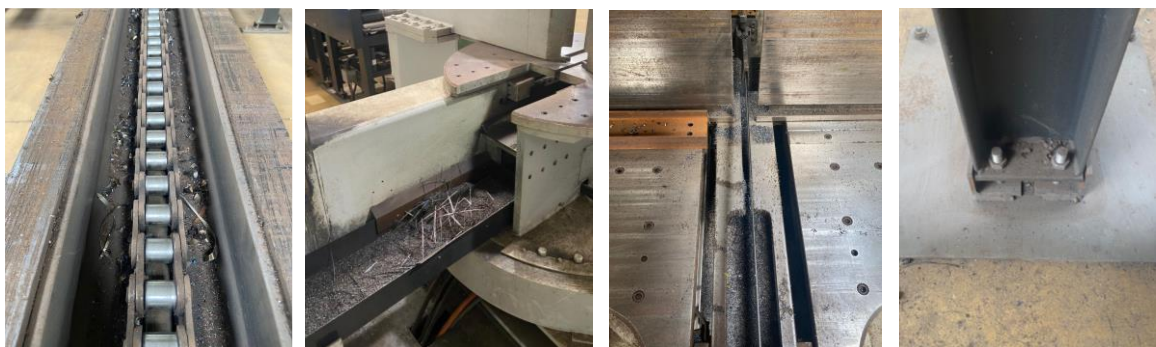
Figura 49- Antes da implementação da Manutenção Autónoma no EQP05 (a)
