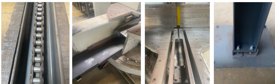
Figura 50- Depois da implementação da Manutenção Autónoma no EQP05 (b)
