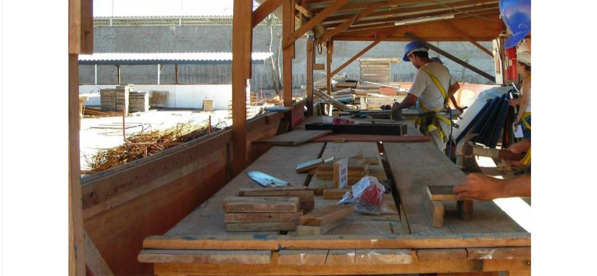
Figura 4.8- Execução de Cofragens [46]
