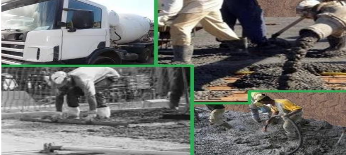
Figura 4.14- Execução, Colocação, Espalhamento e Compactação do Betão
