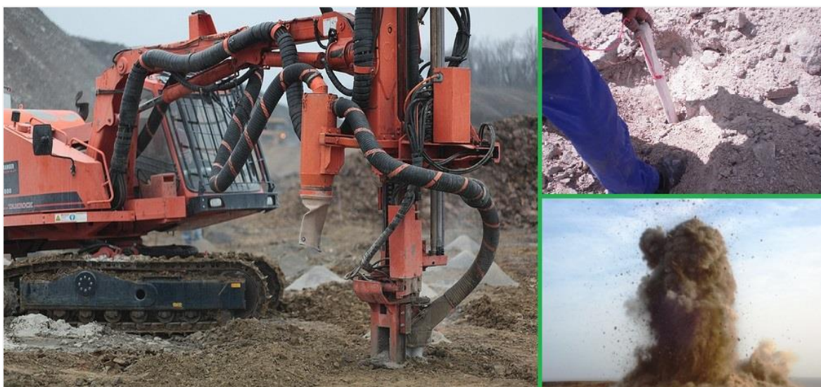
Figura 4.4- Escavação com Recurso a Explosivos
