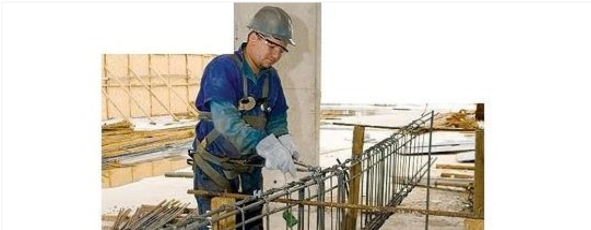
Figura 4.10- Execução das Armaduras [47]
