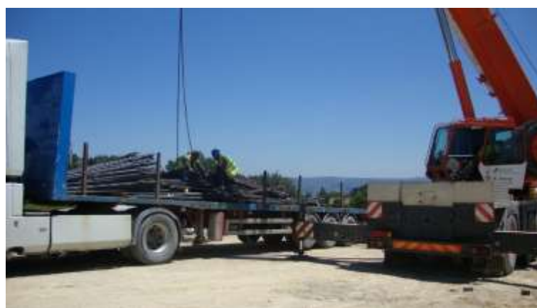
Figura 5.12 – Descarga das armaduras da fundação do Encontro Esquerdo.
