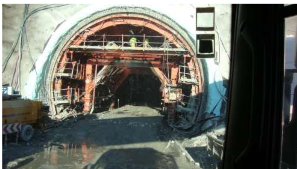
Figura 5.20 – Cofragem e betonagem dos hasteais e abóbada.
