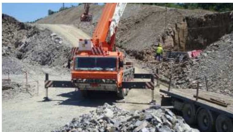
Figura 5.14 – Camião-grua a descarregar as armaduras do pilar da Passagem Superior (PS9).
