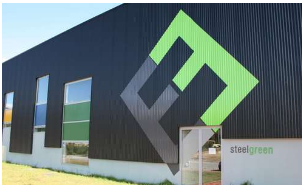
Figura 2.2 – Instalações da Steelgreen, S.A. [1]
