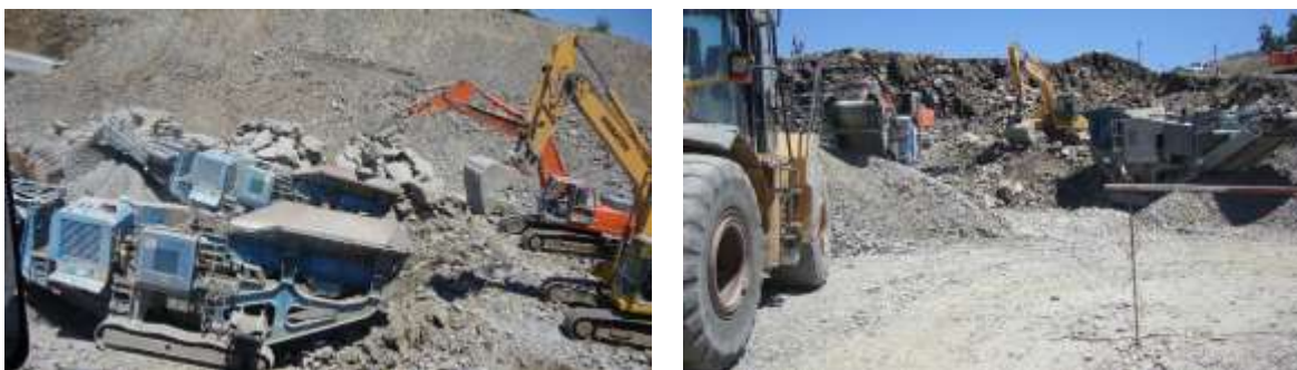
Figura 5.13 – Equipamentos no local da obra.
