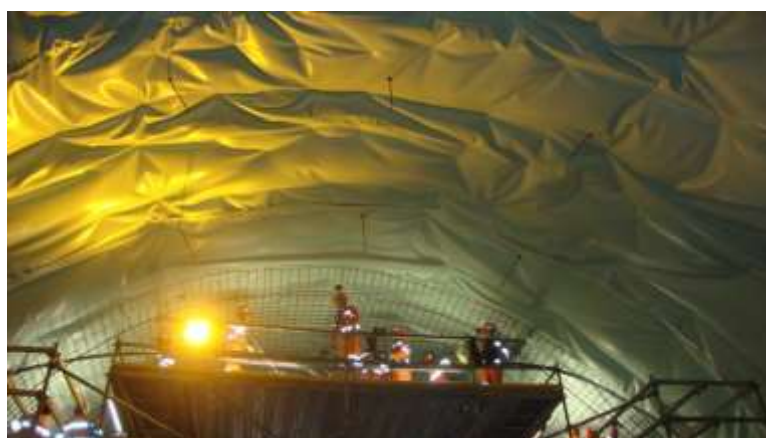
Figura 5.16 – Tela de impermeabilização.
