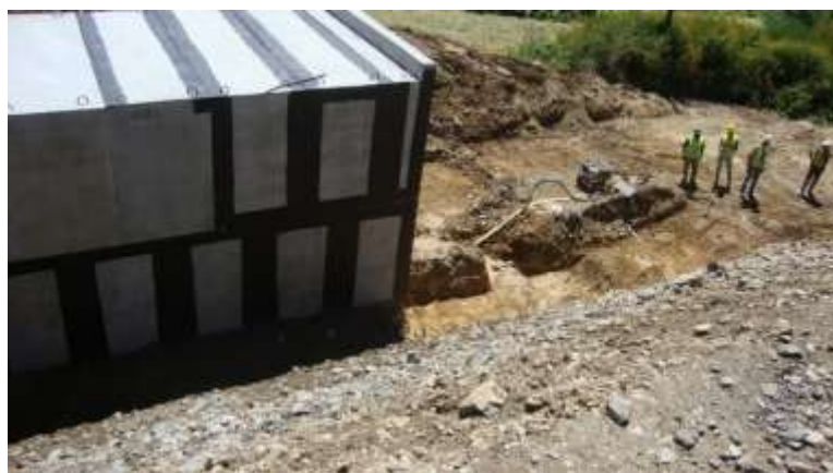
Figura 5.11 – Abertura do cabouco do Encontro Esquerdo.
