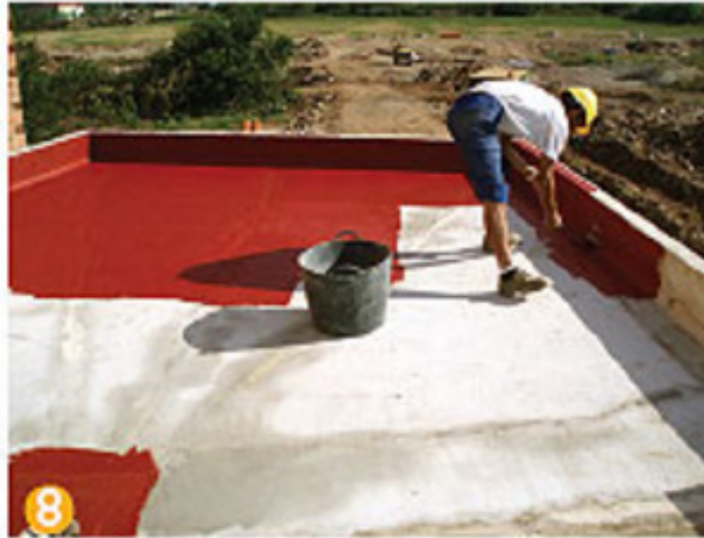
8- Circuitos de captação de energia solar de cobertura.
