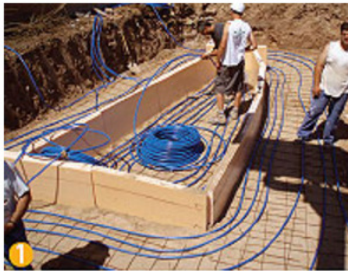
1- Primeiramente se faz necessário criar um núcleo de armazenamento e circuitos intermediários utilizando isolamento térmico.
