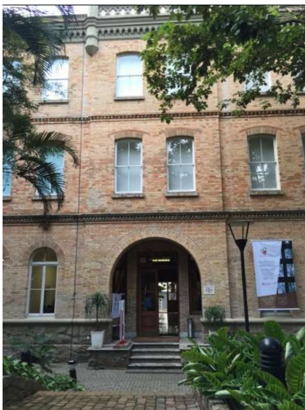
Ilustração 3.1 – Fachada do Edifício Mackenzie.
