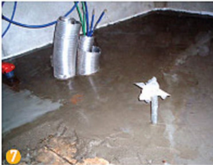
7- Contrapiso sobre material isolante térmico. Esperas para sistema de climatização por tubos contracorrente.
