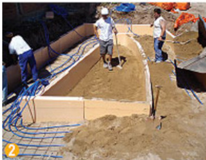
2- Depois fazer uma cobertura de areia sobre circuitos de PPR.
