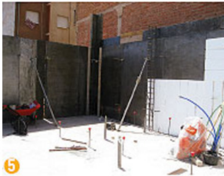
5- Execução de fôrmas com cobertura de EPS para concretagem de paredes.
