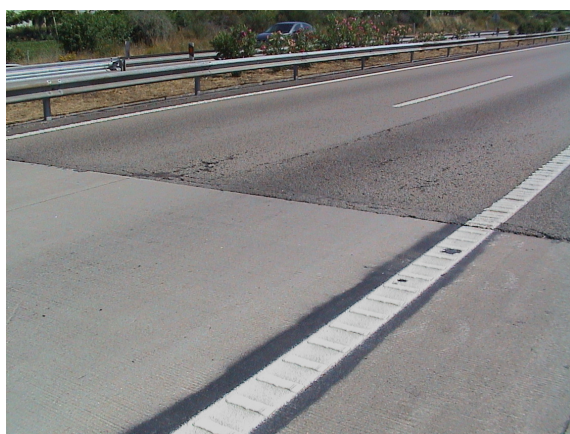
Figura 2 – Início da obra – km 41+570 (fim do trecho em pavimento rígido)
