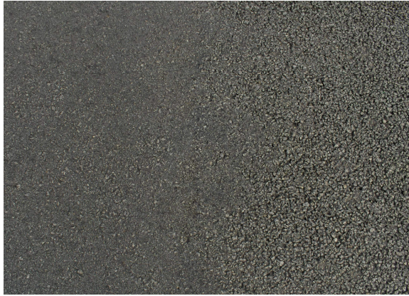
Figura 79 – Zona da transição do betão betuminoso drenante e do betão betuminoso com anti-querosene
