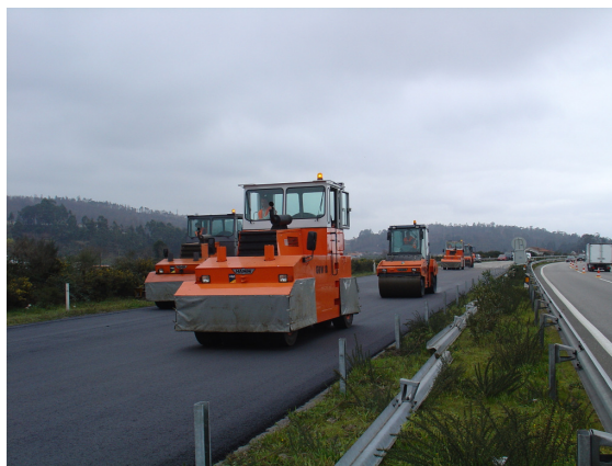
Figura 57 – Operação de compactação com cilindros
