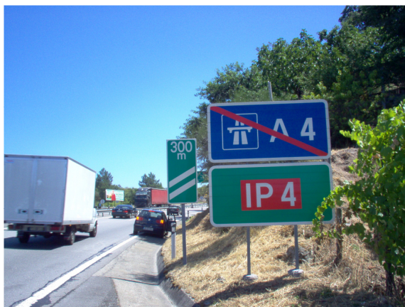
Figura 3 – Fim da obra – km 59+200 (fim da concessão da Brisa)
