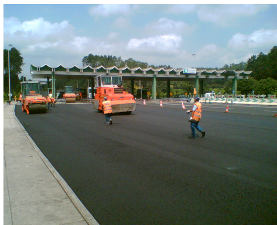
Figura 58 – Operação de compactação na zona da portagem de plena via
