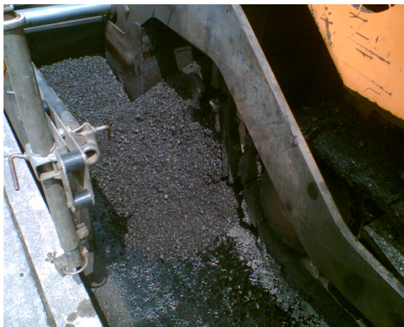
Figura 60 – Espalhamento da mistura com a ABG Titan 225
