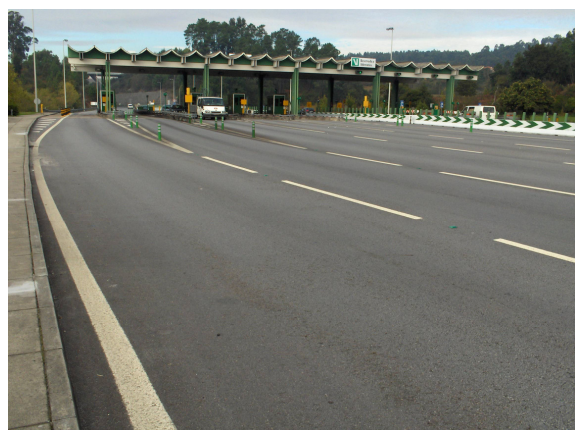
Figura 81 – Aspecto geral da Praça de Portagem de plena via em Amarante (2)
