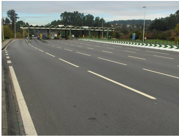
Figura 80 – Aspecto geral da Praça de Portagem de plena via em Amarante
