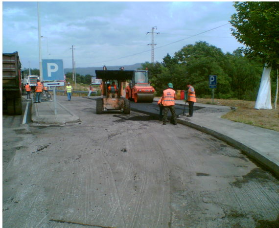
Figura 59 – Parque de estacionamento
