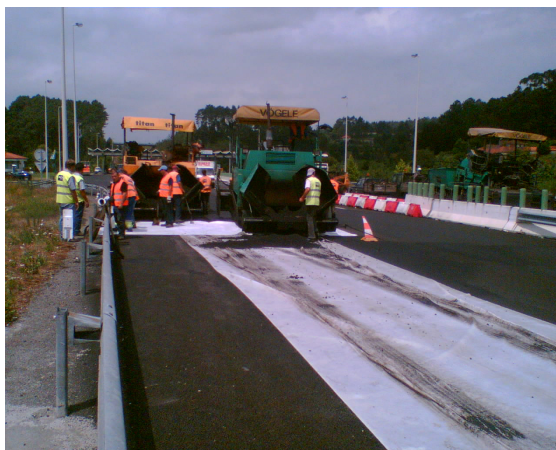
Figura 56 – Espalhamento com pavimentadoras
