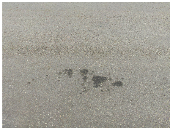
Figura 84 – Pormenor de um derrame (2)
