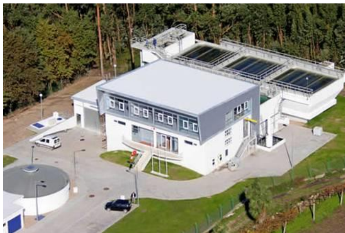
Figura 7 – Estação de tratamento de água do Ferreira
