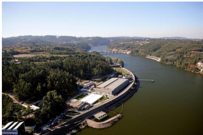
Figura 6 – Estação de tratamento de água de Lever
