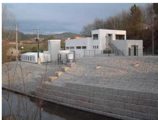
Figura 5 – Estação de tratamento de água do Ferro
