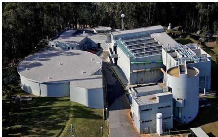
Figura 4 – Estação de tratamento de água de Castelo de Paiva
