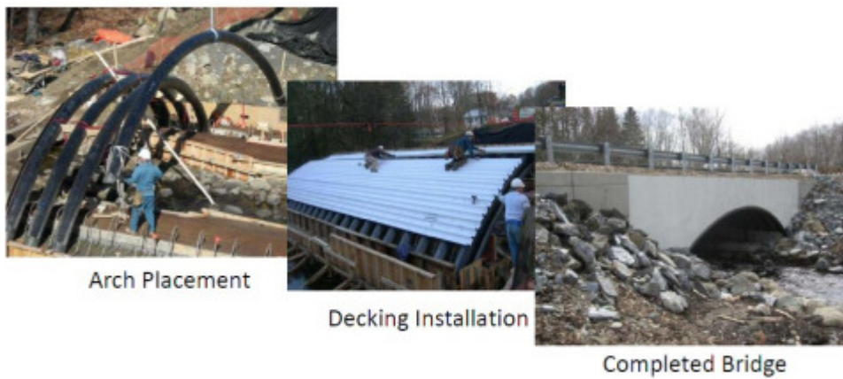
Imagem 3.5 – Utilização em construção de uma ponte. Fonte: Reinforced Plastics.
