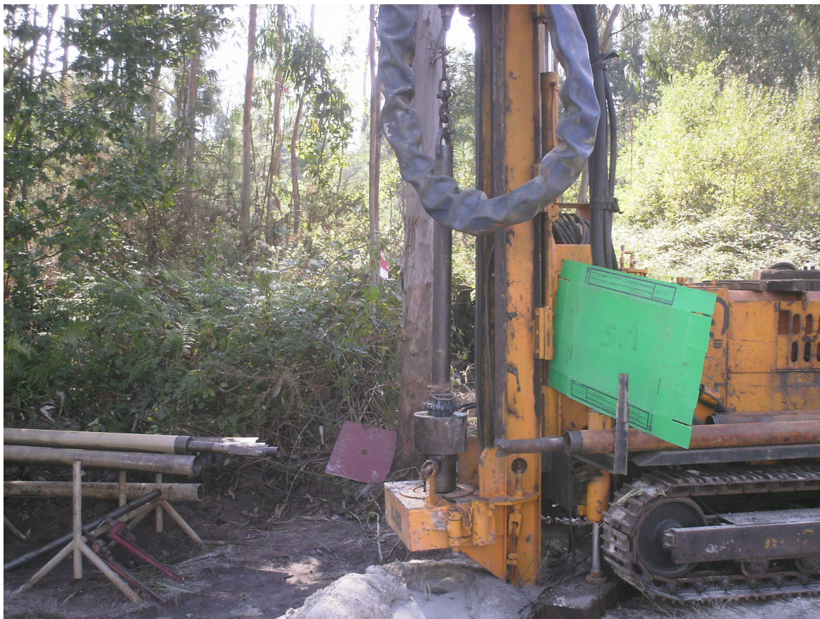
Foto 1 – Equipamento utilizado, Atlas Copco Mustang A-32
