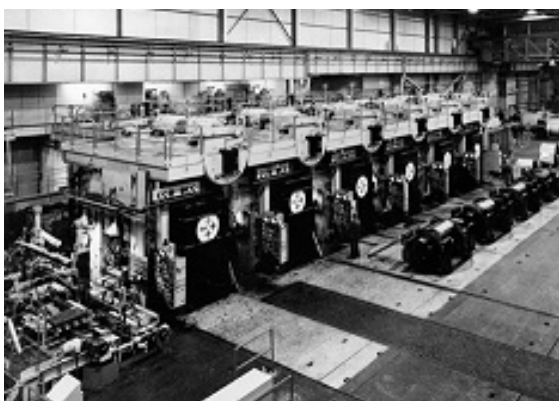
Figura 2.9 – Pormenor do pavimento de uma siderurgia americana em 1967 [6]
