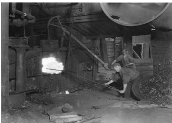
Figura 2.8 – Exemplo de um pavimento industrial na década de 20 [26]
