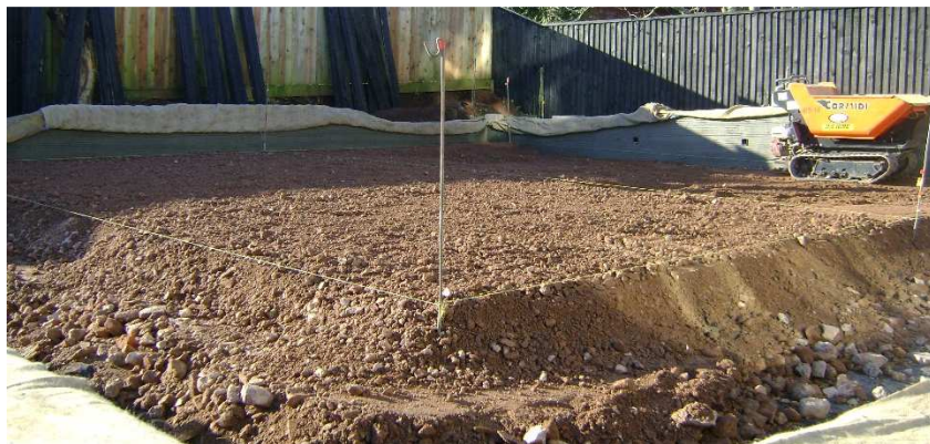
Figura 2.18 – Exemplo de uma sub-base com equipamento de compactação [30]
