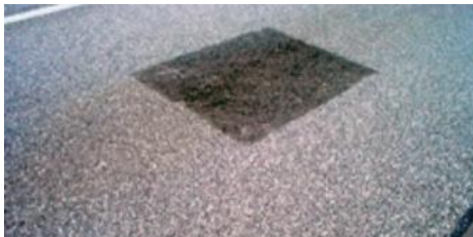
Figura 29: Remendo bem executado (Bernucci et al., 2008)
