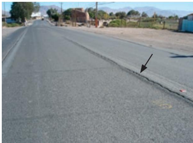
Figura 14: Trinca de retração (Bernuccci et al., 2008)
