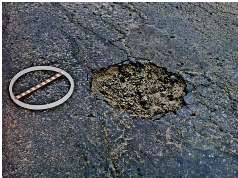
Figura 27: Placa ou buraco (DAER – RS, 1978 Apud. DNIT, 2003a)
