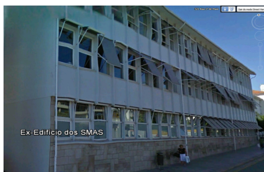
Figura 6-6: Edifício do Ex-SMAS
